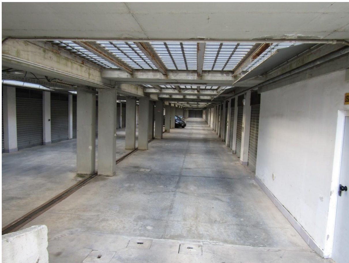
FOTO 9.3 - LOTTO 9 – BOX AUTO IN FOGGIA – PRIMO PIANO INTERRATO
