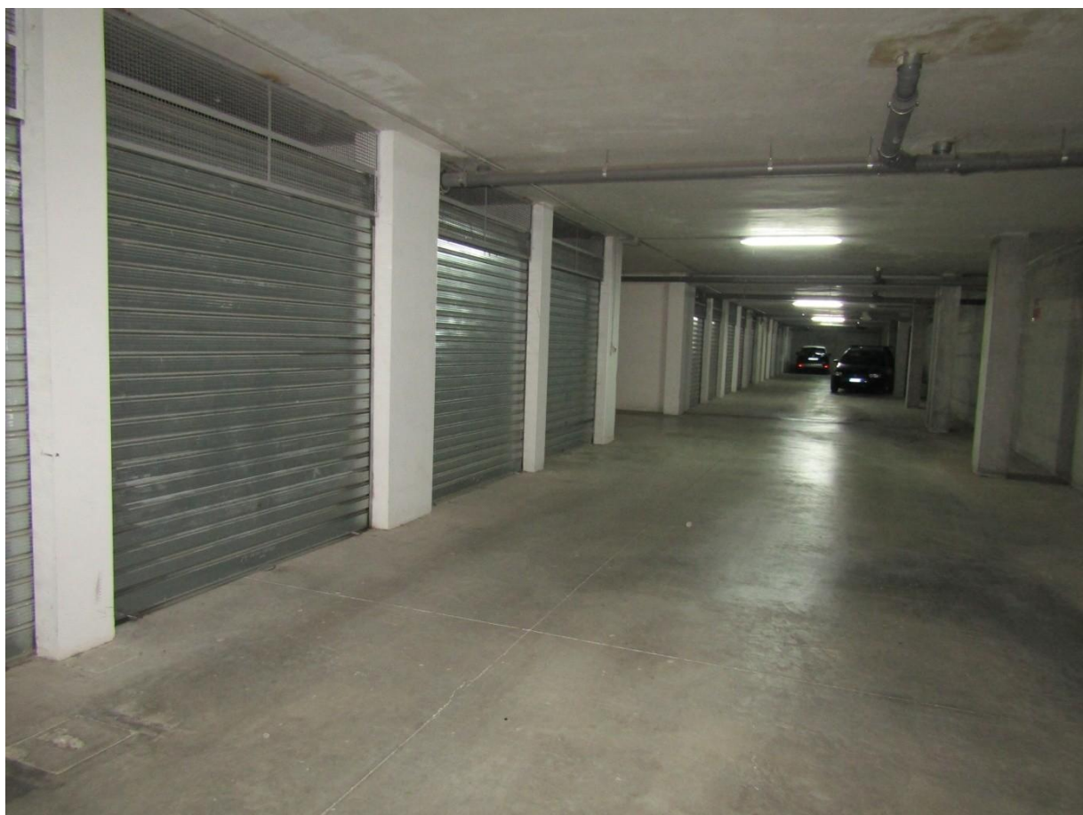
FOTO 9.4 - LOTTO 9 – BOX AUTO IN FOGGIA – PRIMO PIANO INTERRATO – CORSIA DI MANOVRA
