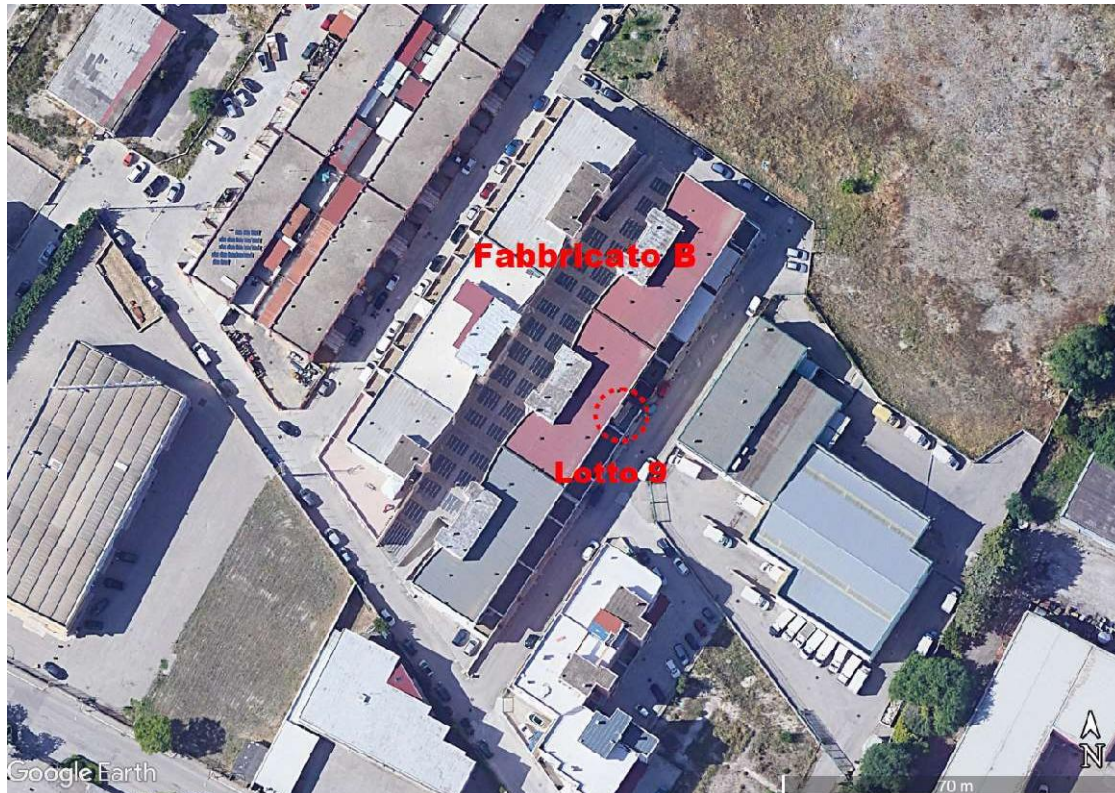
Fig. 1 – LOTTO 9 - Localizzazione dell'immobile all'interno del Fabbricato B sito in Foggia alla via Manfredonia angolo Via delle Casermette - Ortofoto
