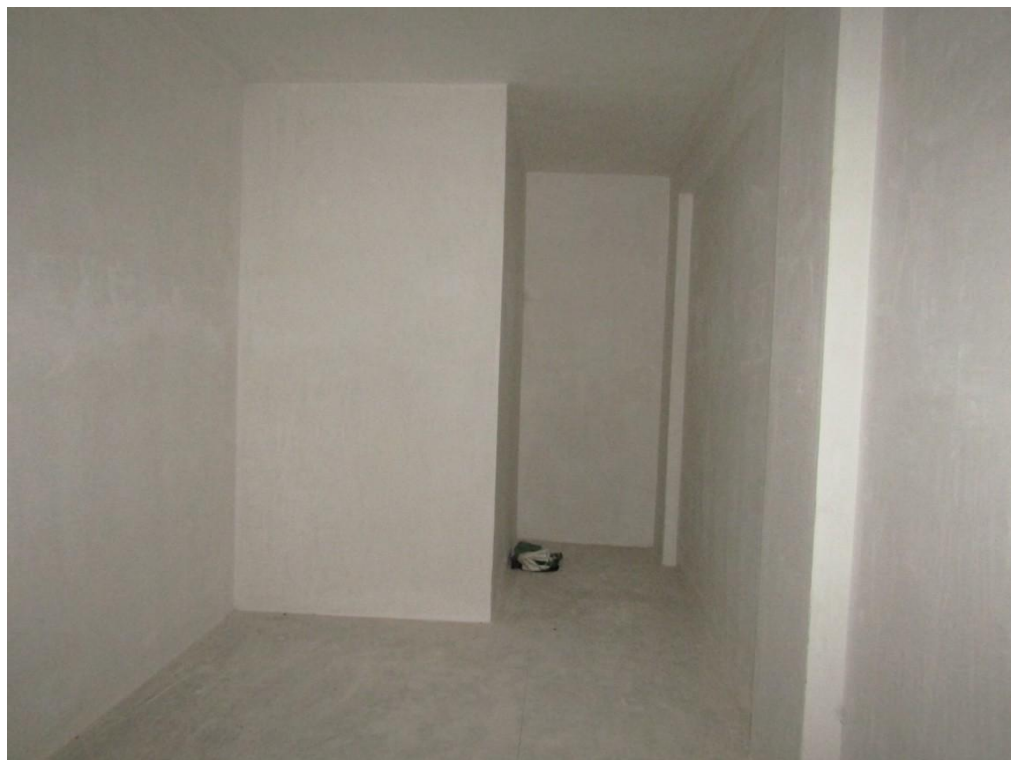
FOTO 24.7 - LOTTO 24 – BOX AUTO IN FOGGIA – PRIMO PIANO INTERRATO – INTERNO
