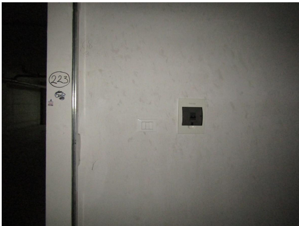
FOTO 24.9 - LOTTO 24 – BOX AUTO IN FOGGIA – PRIMO PIANO INTERRATO – INTERNO
