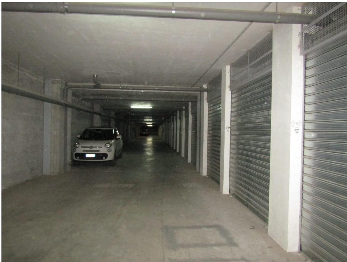
FOTO 24.4 - LOTTO 24 – BOX AUTO IN FOGGIA – PRIMO PIANO INTERRATO – CORSIA DI MANOVRA
