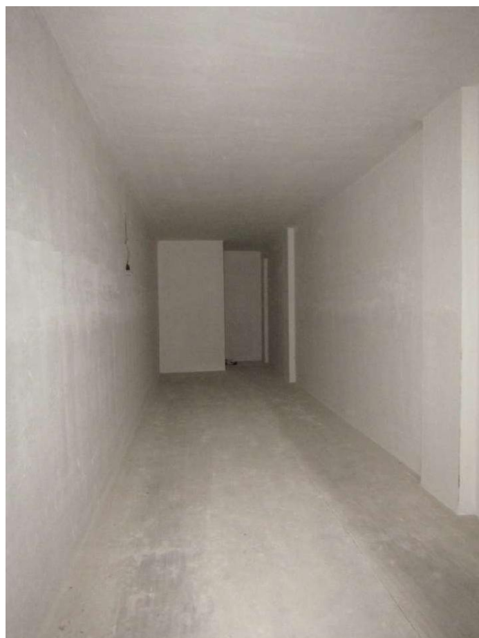
FOTO 24.6 - LOTTO 24 – BOX AUTO IN FOGGIA – PRIMO PIANO INTERRATO – INTERNO
