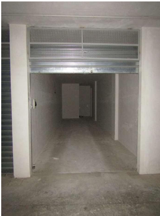
FOTO 24.5 - LOTTO 24 – BOX AUTO IN FOGGIA – PRIMO PIANO INTERRATO – INGRESSO
