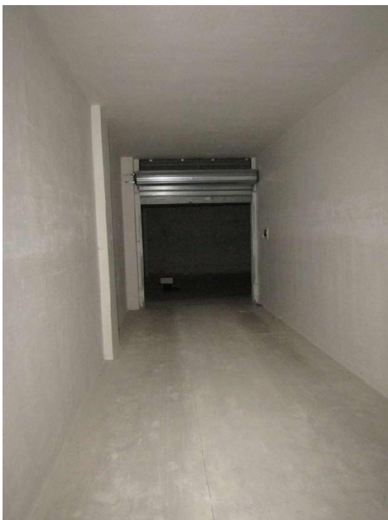
FOTO 24.8 - LOTTO 24 – BOX AUTO IN FOGGIA – PRIMO PIANO INTERRATO – INTERNO
