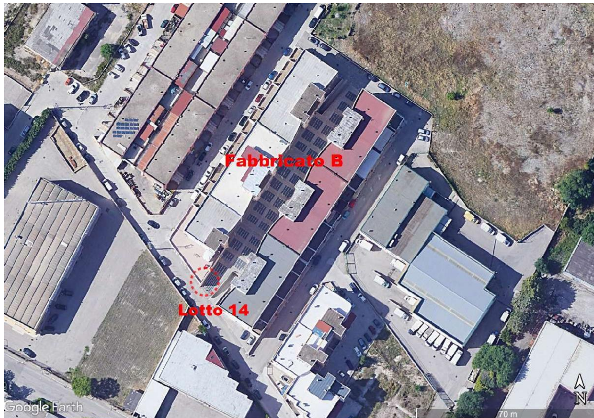
Fig. 1 – LOTTO 14 - Localizzazione dell'immobile all'interno del Fabbricato B sito in Foggia alla via Manfredonia angolo Via delle Casermette - Ortofoto
