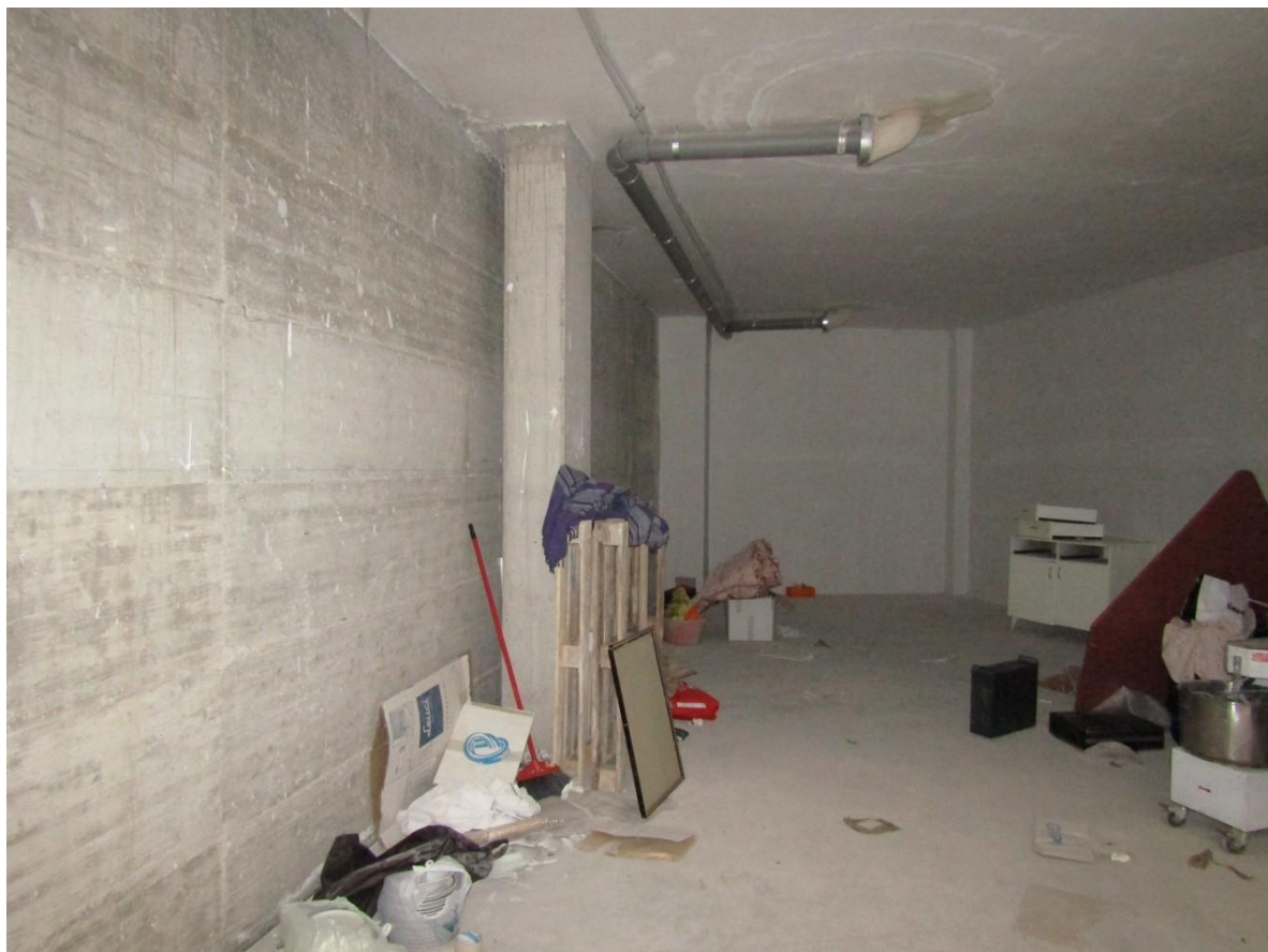
FOTO 14.6 - LOTTO 14 – BOX AUTO IN FOGGIA – PRIMO PIANO INTERRATO – INTERNO
