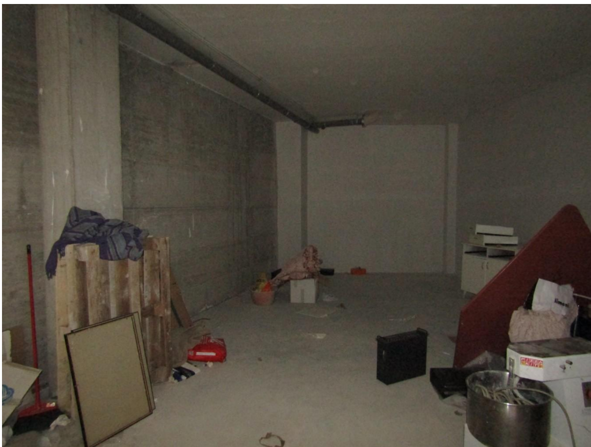
FOTO 14.5 - LOTTO 14 – BOX AUTO IN FOGGIA – PRIMO PIANO INTERRATO – INTERNO
