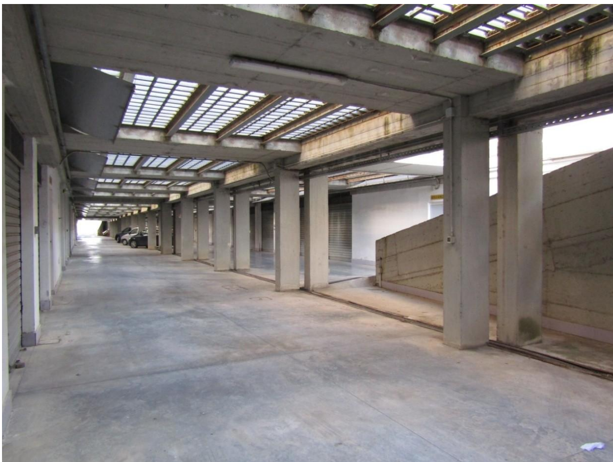
FOTO 14.3 - LOTTO 14 – BOX AUTO IN FOGGIA – PRIMO PIANO INTERRATO - CORSIA DI MANOVRA
