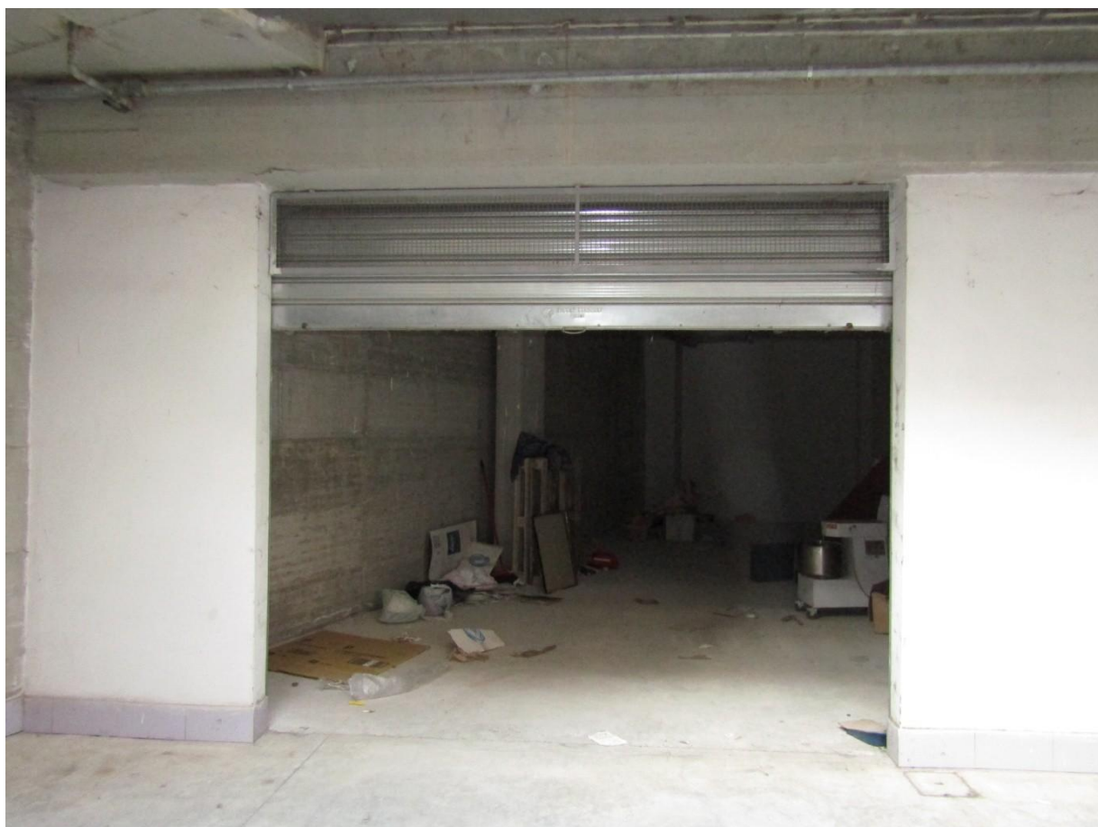
FOTO 14.4 - LOTTO 14 – BOX AUTO IN FOGGIA – PRIMO PIANO INTERRATO – INGRESSO
