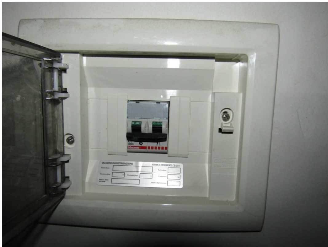
FOTO 11.9 - LOTTO 11 – BOX AUTO IN FOGGIA – PRIMO PIANO INTERRATO – INTERNO
