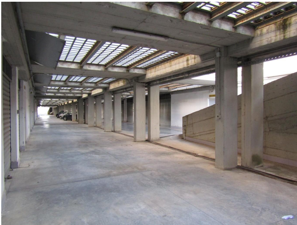
FOTO 11.3 - LOTTO 11 – BOX AUTO IN FOGGIA – PRIMO PIANO INTERRATO
