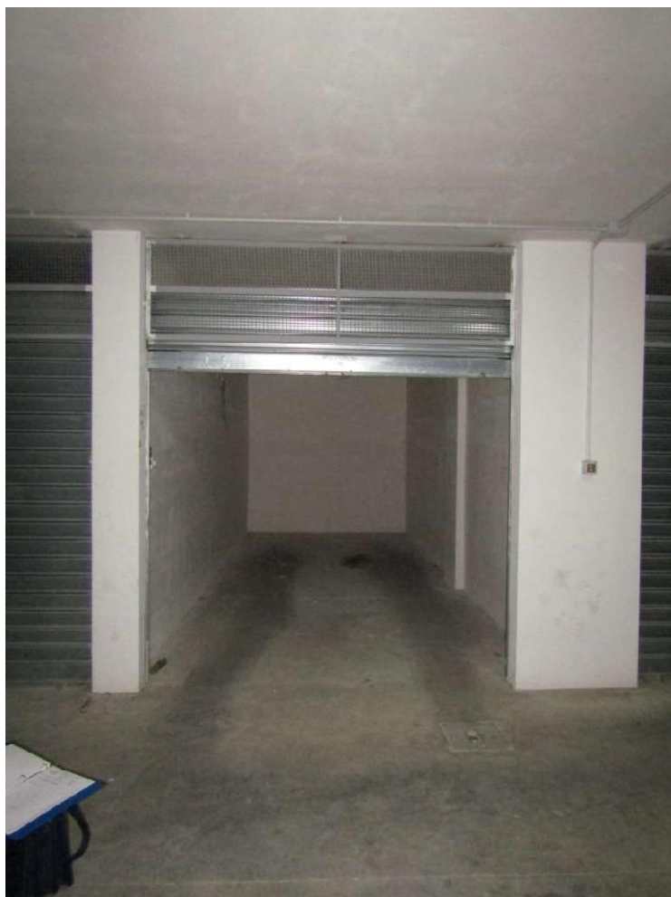
FOTO 11.6 - LOTTO 11 – BOX AUTO IN FOGGIA – PRIMO PIANO INTERRATO – INGRESSO
