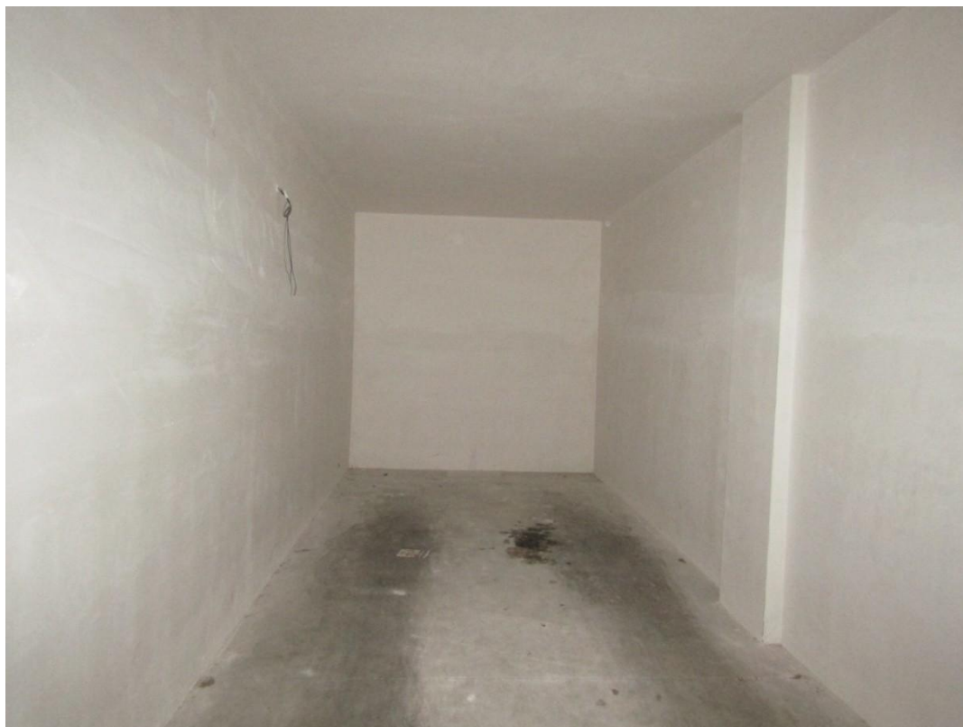
FOTO 11.7 - LOTTO 11 – Box AUTO IN FOGGIA – PRIMO PIANO INTERRATO – INTERNO
