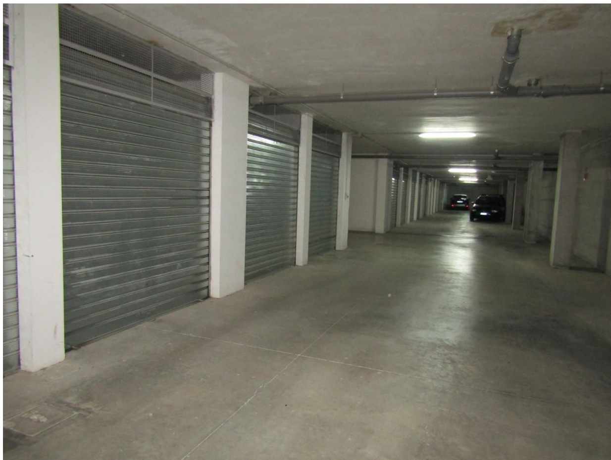
FOTO 11.4 - LOTTO 11 – BOX AUTO IN FOGGIA – PRIMO PIANO INTERRATO – CORSIA DI MANOVRA
