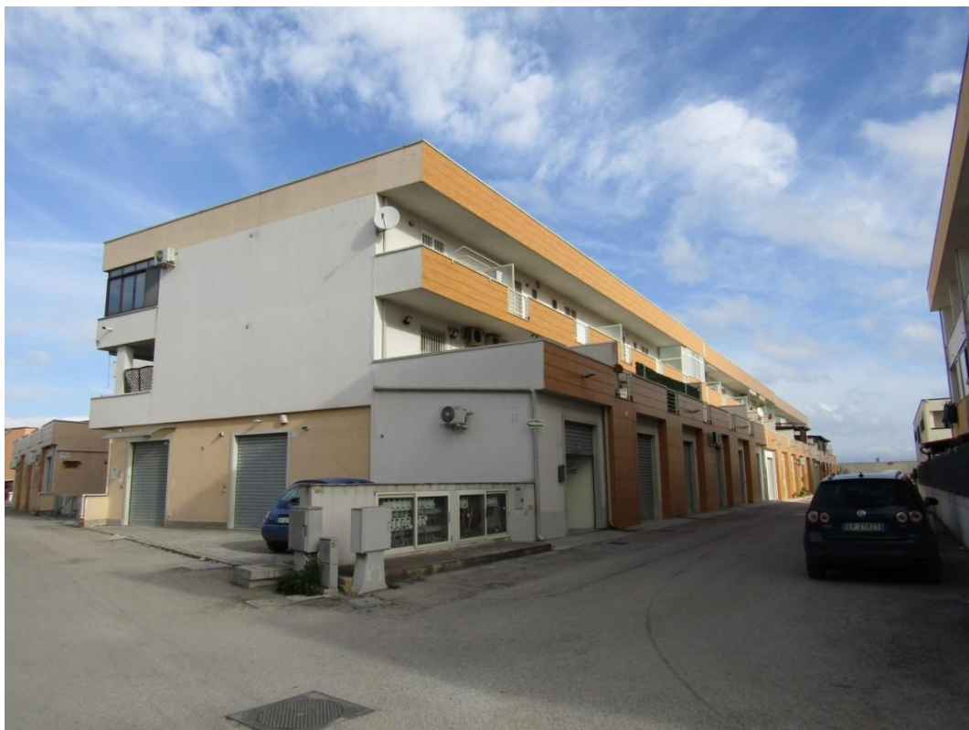
FOTO 11.1 - LOTTO 11 – BOX AUTO IN FOGGIA – FABBRICATO B
