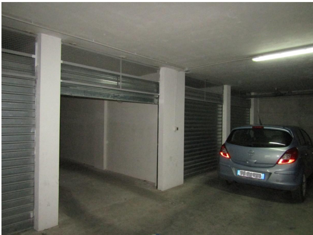
FOTO 11.5 - LOTTO 11 – BOX AUTO IN FOGGIA – PRIMO PIANO INTERRATO – INGRESSO
