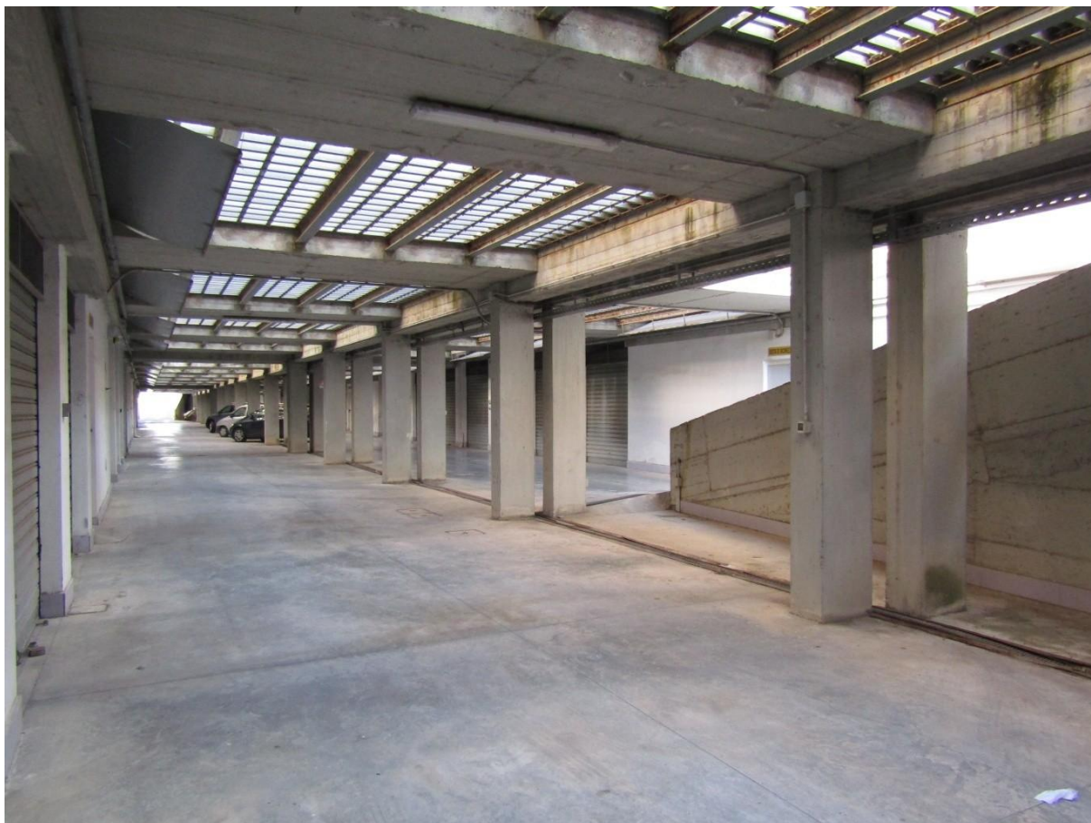
FOTO 10.3 - LOTTO 10 – BOX AUTO IN FOGGIA – PRIMO PIANO INTERRATO
