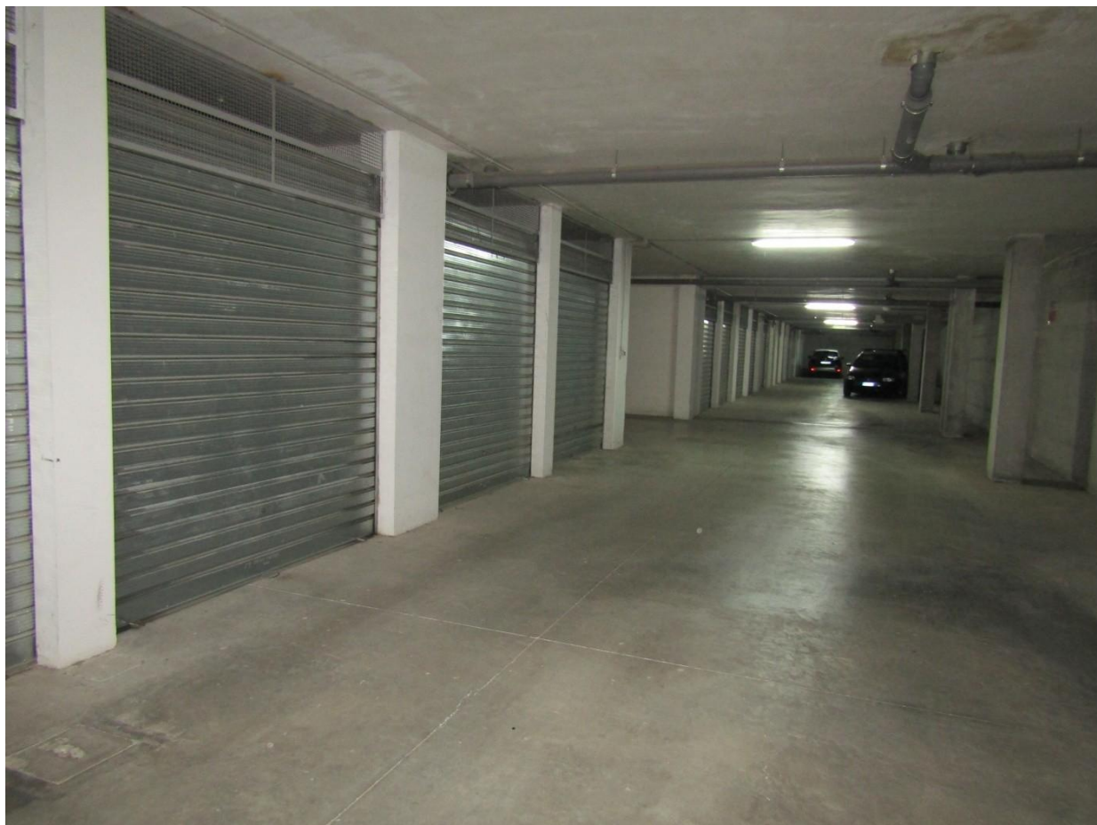
FOTO 10.4 - LOTTO 10 – BOX AUTO IN FOGGIA – PRIMO PIANO INTERRATO – CORSIA DI MANOVRA
