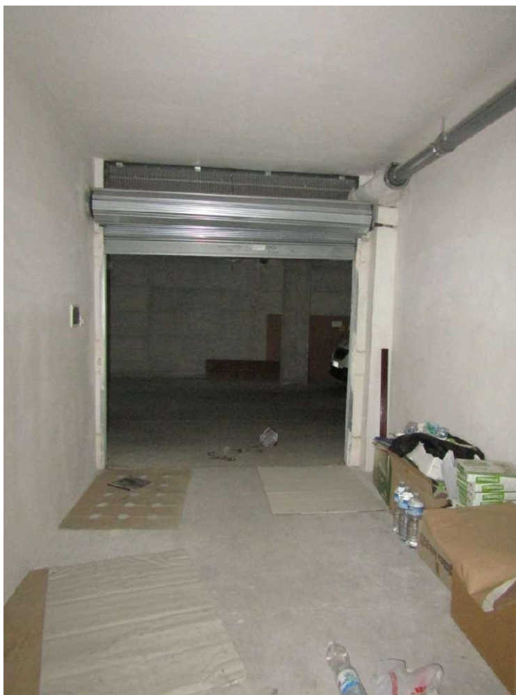
FOTO 10.7 - LOTTO 10 – BOX AUTO IN FOGGIA – PRIMO PIANO INTERRATO – INTERNO
