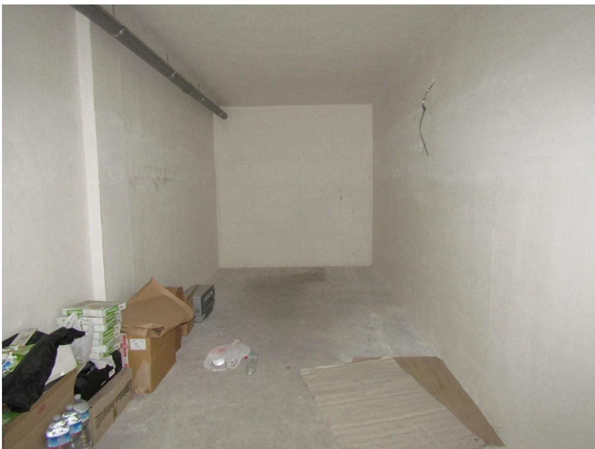
FOTO 10.6 - LOTTO 10 – BOX AUTO IN FOGGIA – PRIMO PIANO INTERRATO – INTERNO
