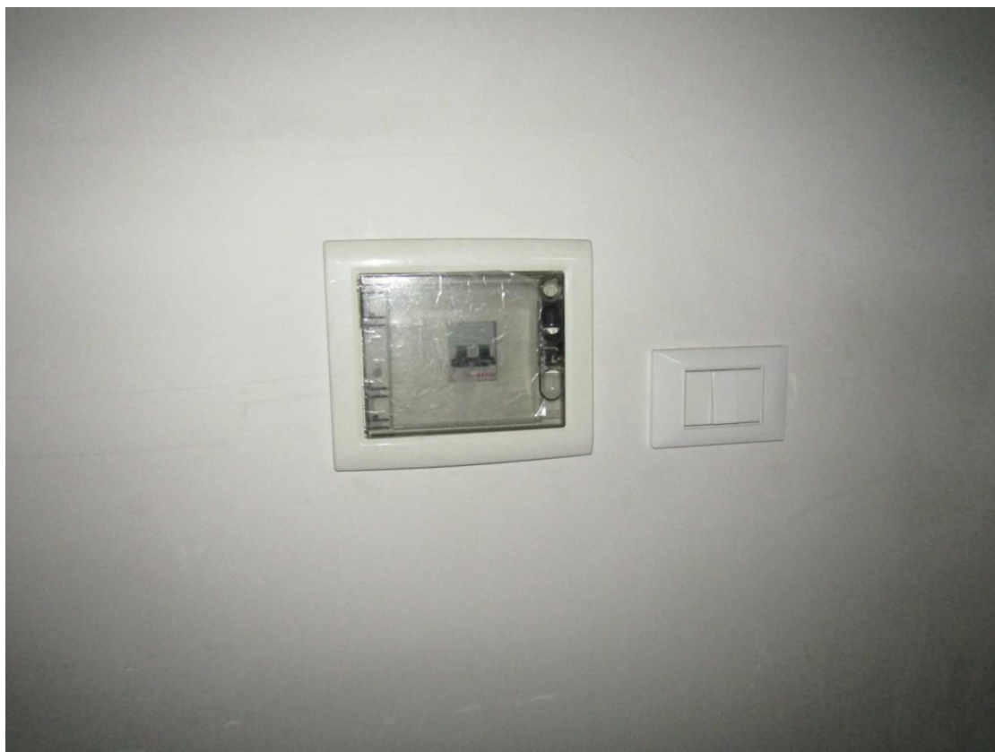
FOTO 10.8 - LOTTO 10 – BOX AUTO IN FOGGIA – PRIMO PIANO INTERRATO – INTERNO
