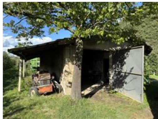
vista edificio agricolo in p.ed. 1929
