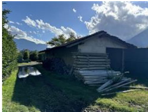
vista edificio agricolo in p.ed. 1929
