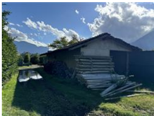
vista edificio agricolo in p.ed. 1929
