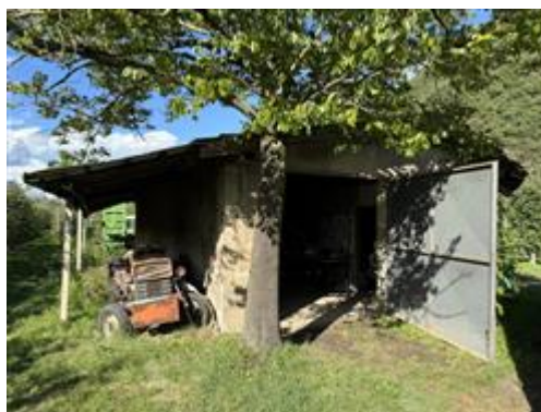
vista edificio agricolo in p.ed. 1929
