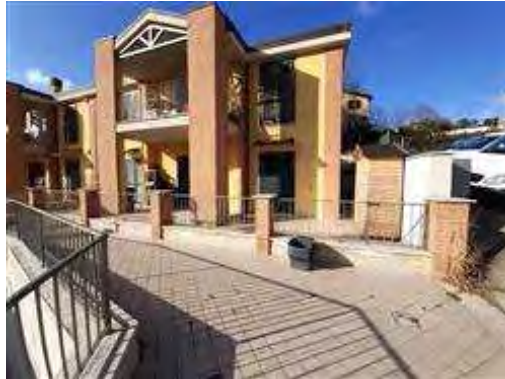
Veduta a valle del fabbricato
