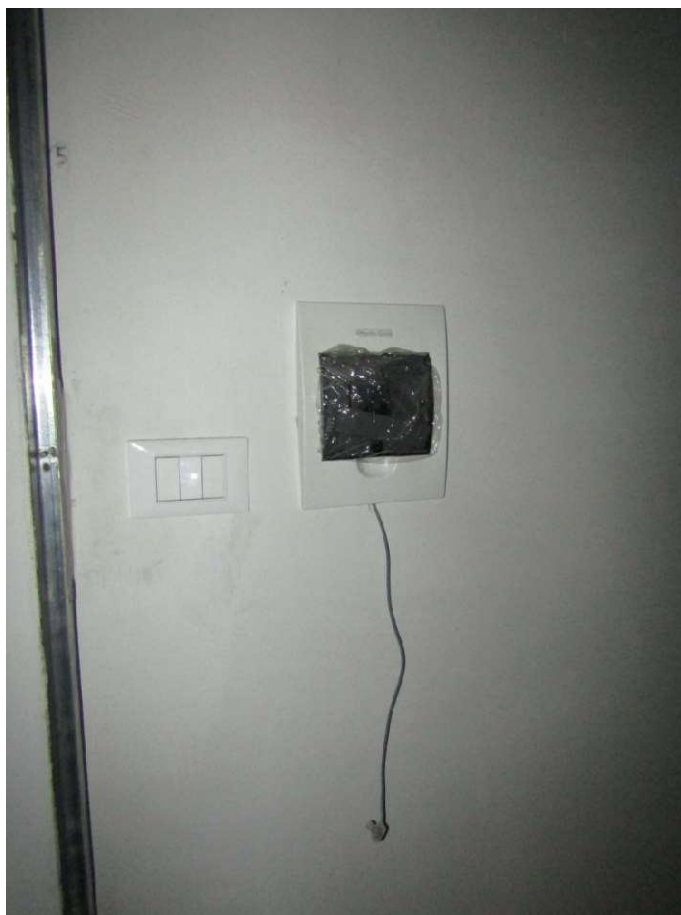
FOTO 8.10 - LOTTO 8 – BOX AUTO IN FOGGIA – PRIMO PIANO INTERRATO – INTERNO
