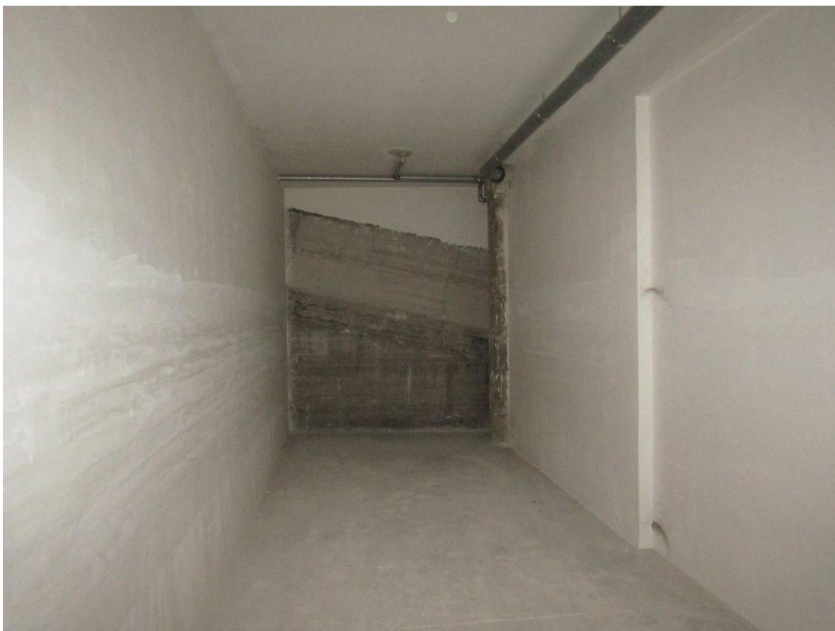
FOTO 8.7 - LOTTO 8 – BOX AUTO IN FOGGIA – PRIMO PIANO INTERRATO – INTERNO
