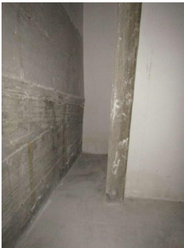
FOTO 8.8 - LOTTO 8 – BOX AUTO IN FOGGIA – PRIMO PIANO INTERRATO – INTERNO
