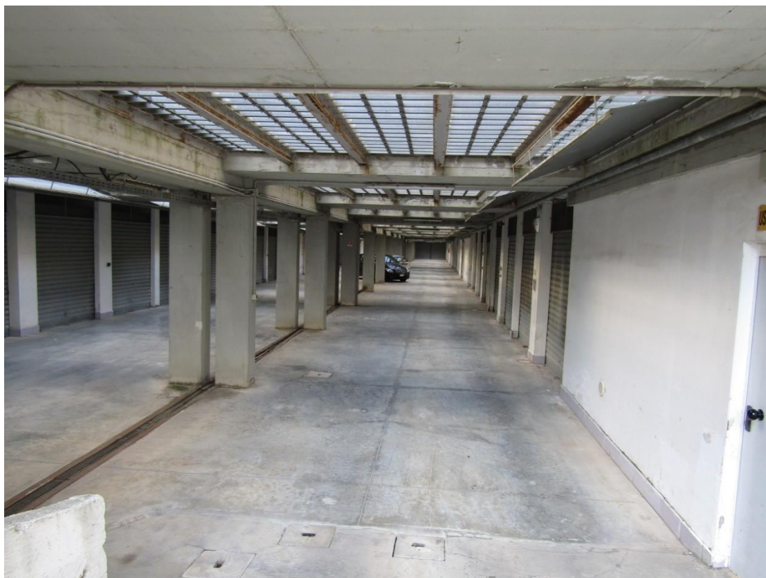
FOTO 8.3 - LOTTO 8 – BOX AUTO IN FOGGIA – PRIMO PIANO INTERRATO
