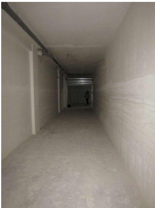
FOTO 8.9 – LOTTO 8 – BOX AUTO IN FOGGIA – PRIMO PIANO INTERRATO – INTERNO
