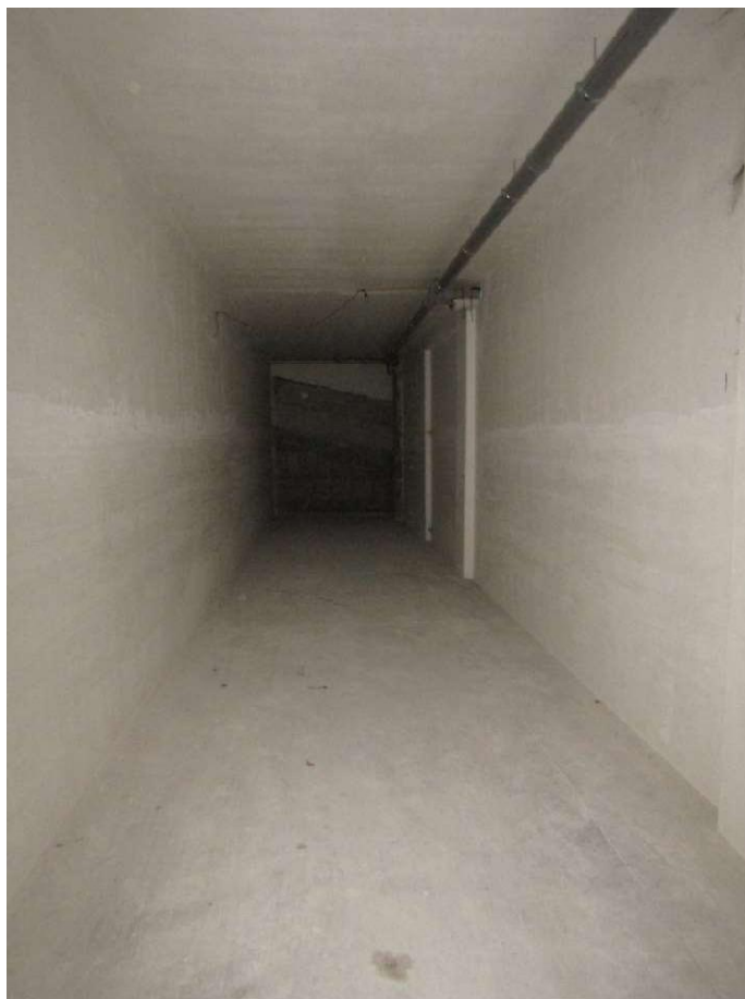
FOTO 8.6 - LOTTO 8 – BOX AUTO IN FOGGIA – PRIMO PIANO INTERRATO – INTERNO
