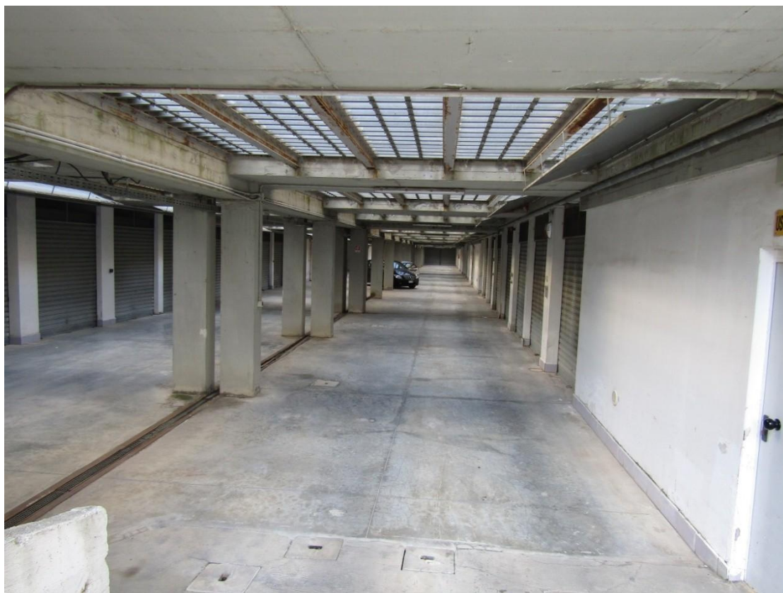
FOTO 7.3 - LOTTO 7 – BOX AUTO IN FOGGIA – PRIMO PIANO INTERRATO
