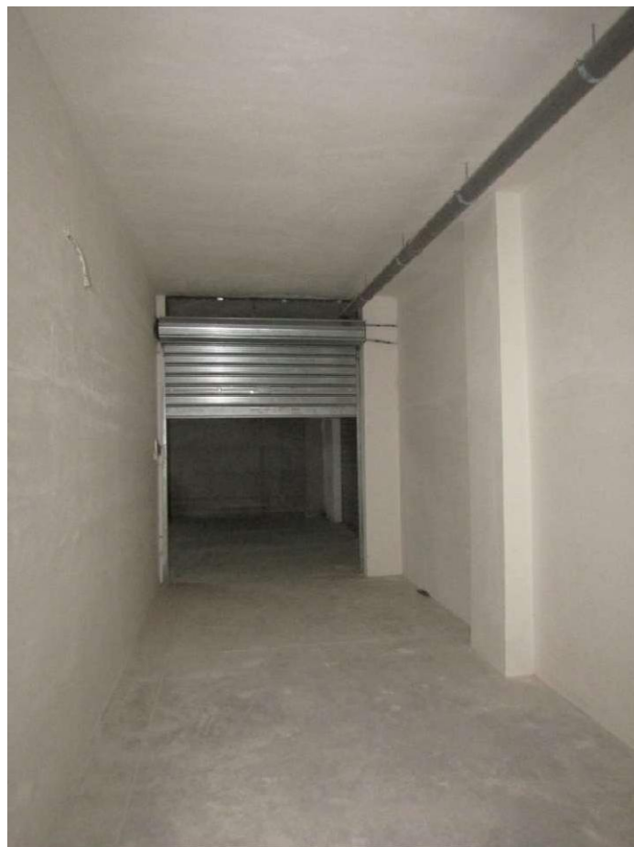
FOTO 7.8 - LOTTO 7 – BOX AUTO IN FOGGIA – PRIMO PIANO INTERRATO – INTERNO
