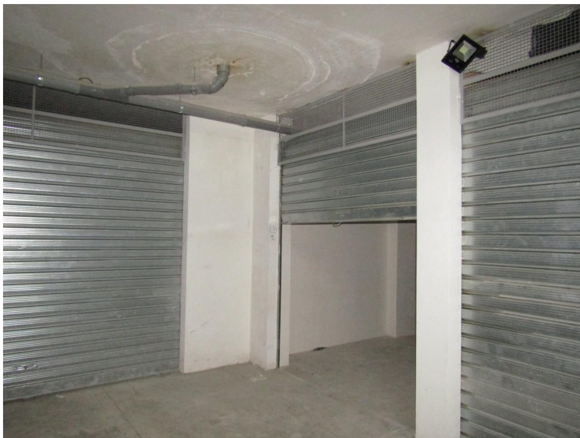
FOTO 7.5 - LOTTO 7 – BOX AUTO IN FOGGIA – PRIMO PIANO INTERRATO – INGRESSO/CORSIA DI MANOVRA
