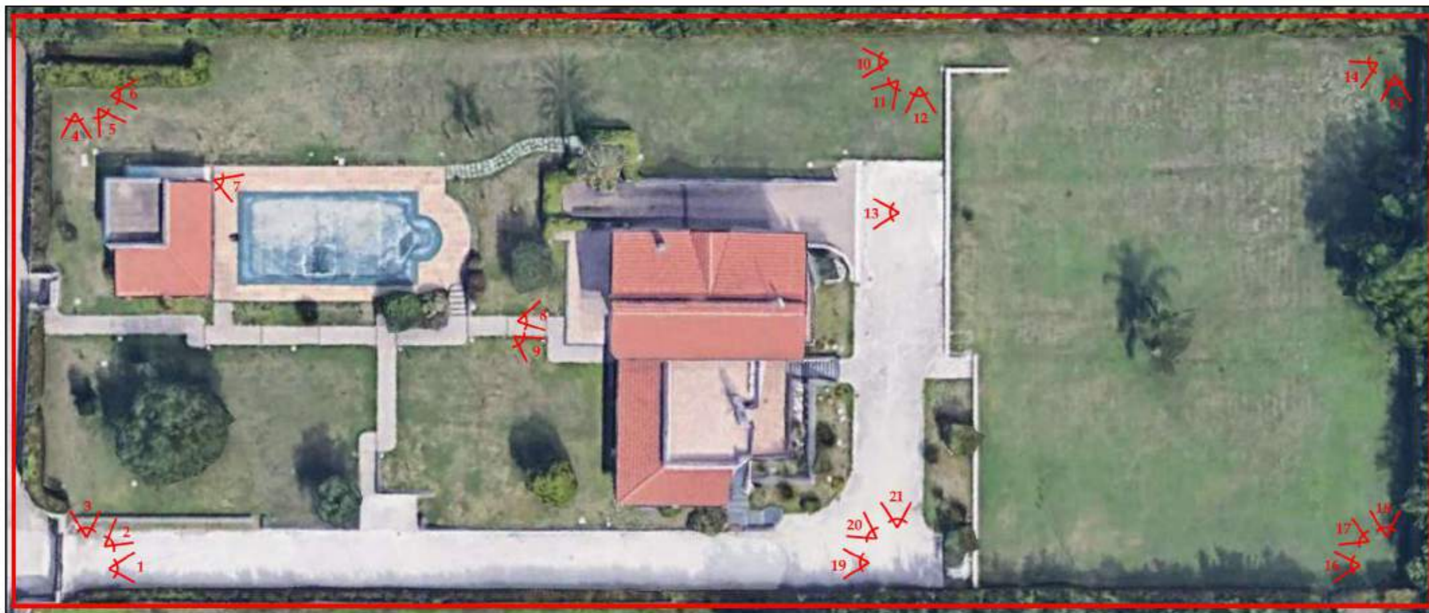
Figura 1: Vista di insieme con indicazione dei coni ottici
