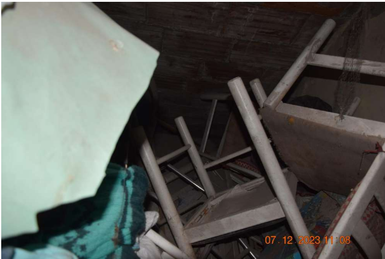
Foto interna – Vano Soffitta
