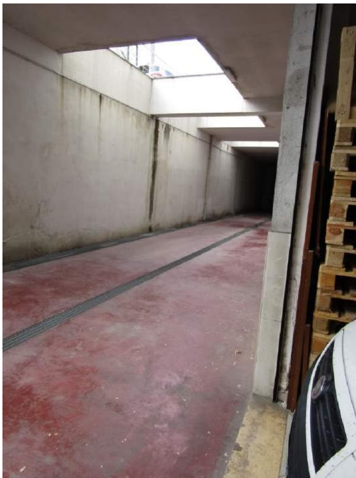
Foto 1.15 - LOTTO 1 - LABORATORIO ARTIGIANALE IN FOGGIA - PRIMO PIANO INTERRATO - CORSIA DI MANOVRA
