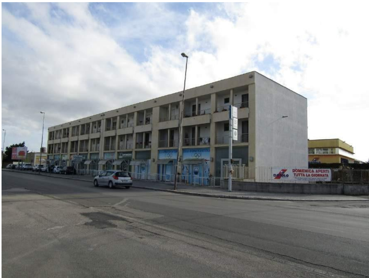
Foto 1.1 - LOTTO 1 - LABORATORIO ARTIGIANALE IN FOGGIA - FABBRICATO A - PROSPETTO PRINCIPALE
