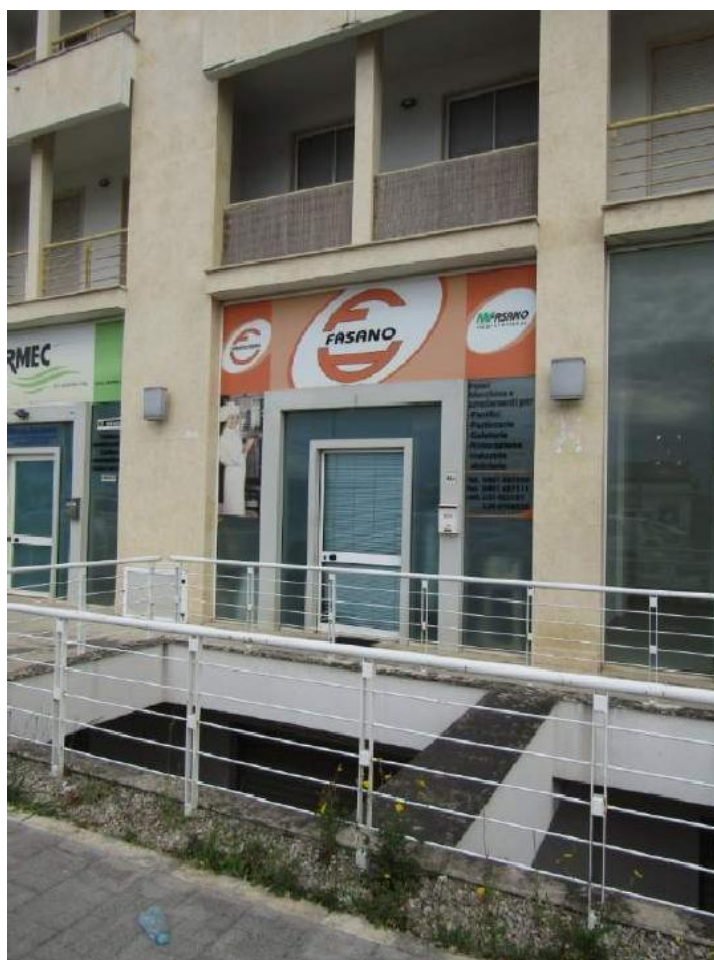
FOTO 1.6 - LOTTO 1 - LABORATORIO ARTIGIANALE IN FOGGIA - INGRESSO SU VIA MANFREDONIA N. 48/4
