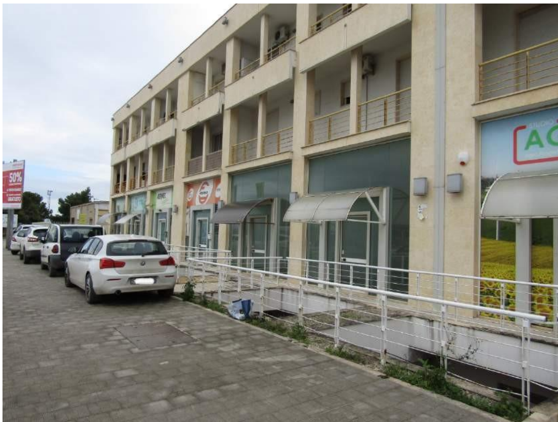
FOTO 1.5 - LOTTO 1 - LABORATORIO ARTIGIANALE IN FOGGIA - FABBRICATO A - PROSPETTO PRINCIPALE
