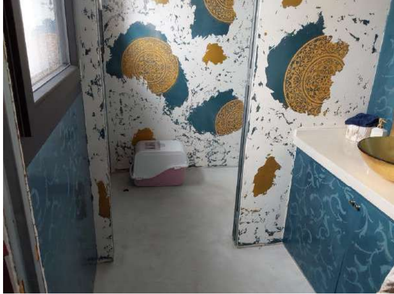
135_bagno piano primo
