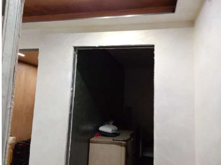
115_corridoio piano terra
