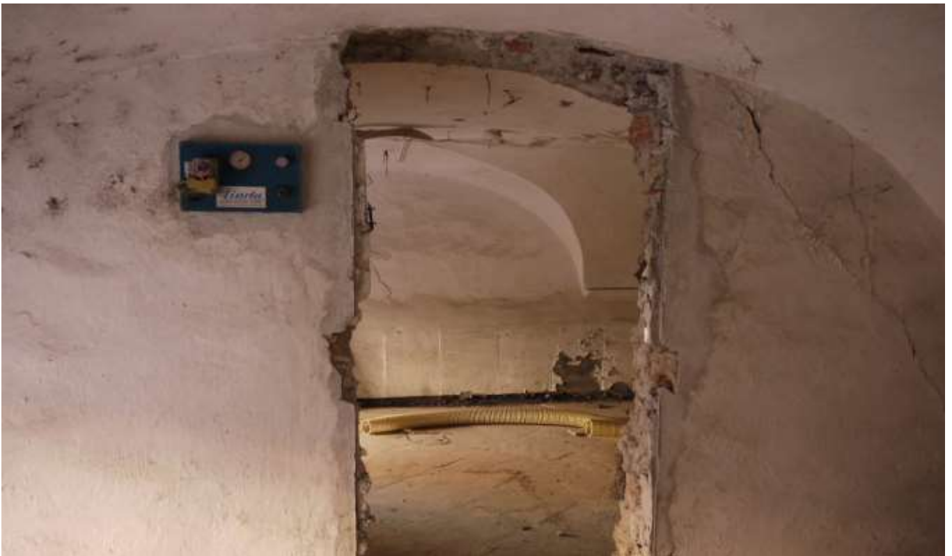
CORPO A.2 - Locali ex farmacia viste interne dei locali
