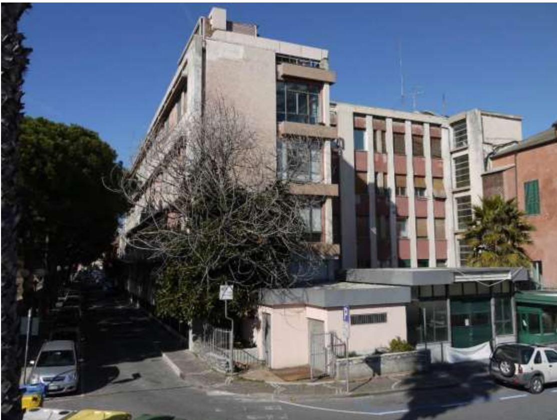
CORPO B – Proprietà Fallimento G.S.I.I. S.R.L. viste di insieme: Porzioni del complesso monumentale e della manica nuova
