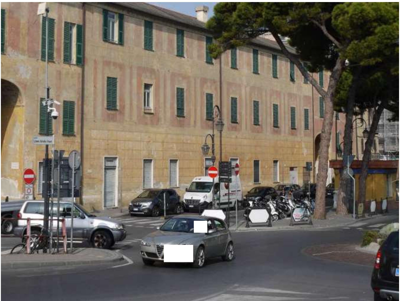
CORPO A.2 - Locali ex farmacia viste esterne – affacci ed ingresso su piazza del Popolo
