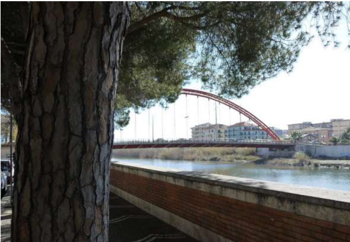
Ex complesso ospedaliero – viste di insieme su Lungo Centa – Via Trento Edifici anni '50
