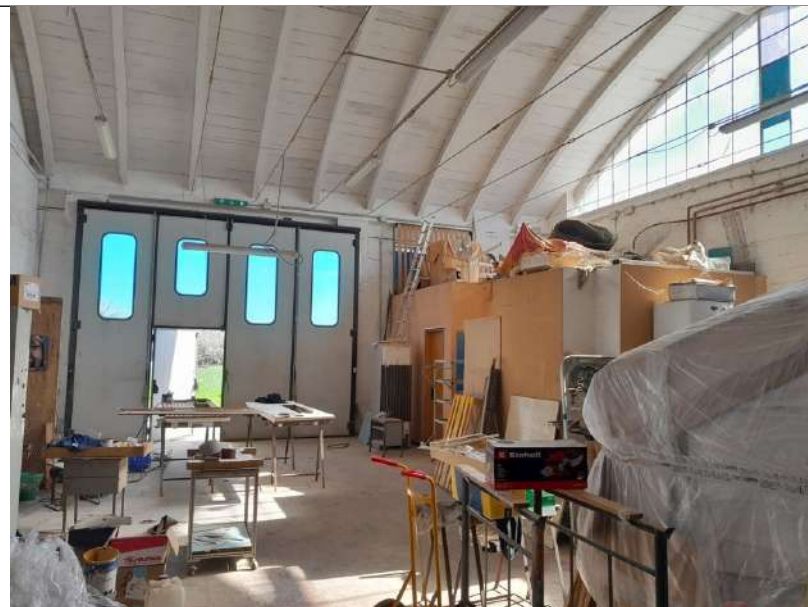
Foto 3.15. – Blocco H: Opificio. Porta di accesso dall'esterno
