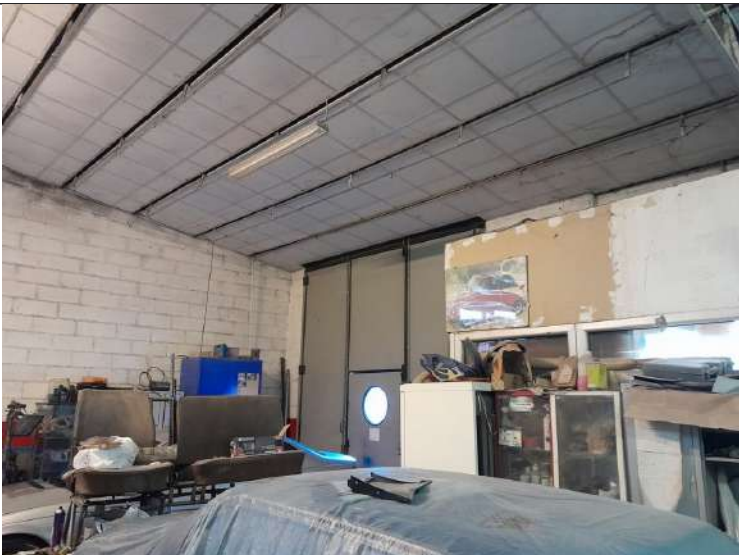
Foto 4.02. – Edificio A – opificio
