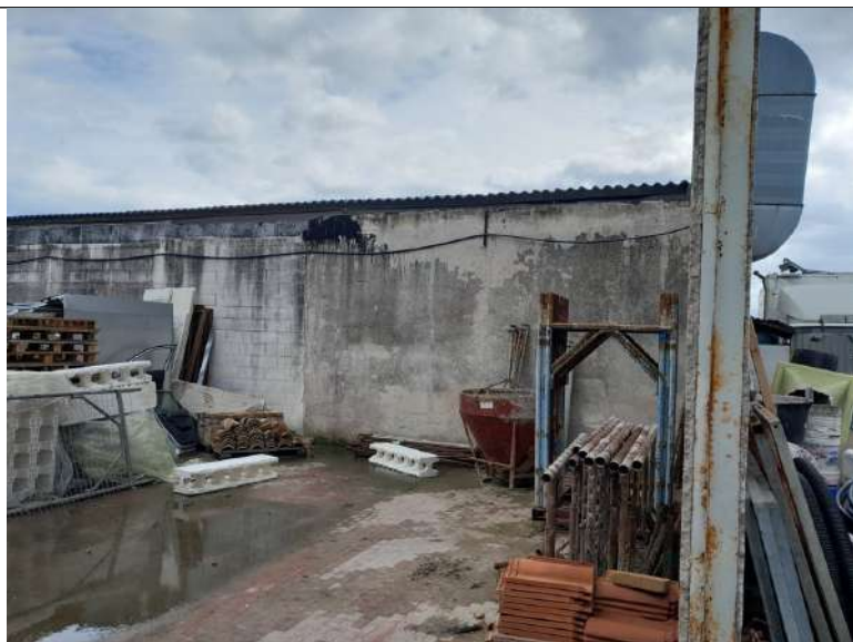
Foto 4.16. – Edificio B (privo di copertura): interno
