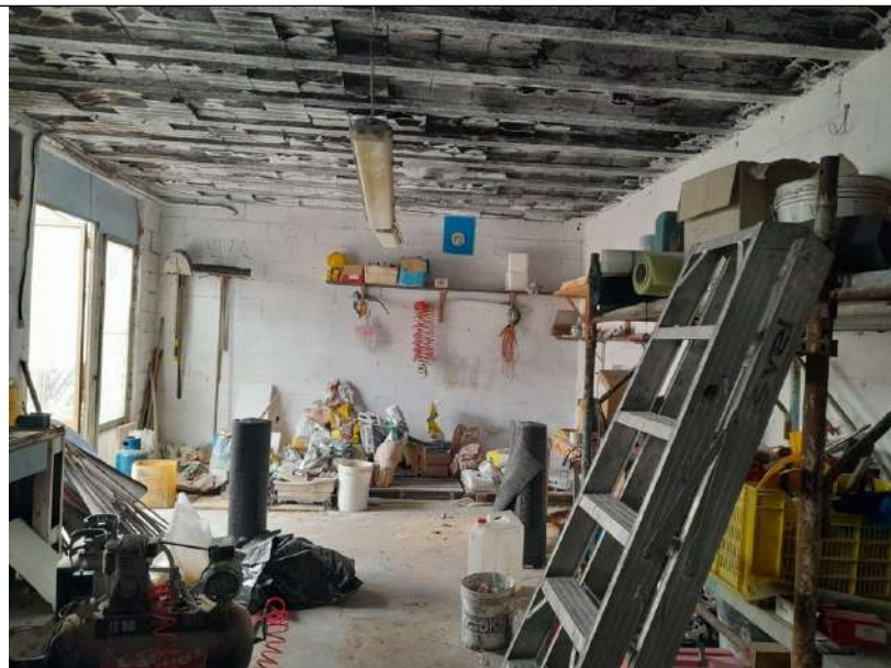
Foto 4.15c. – (destra): Edificio D: locale ex centrale termica
