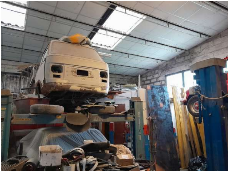
Foto 4.03. – Edificio A – opificio
