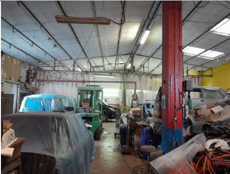
Foto 4.04. – Edificio A – opificio
