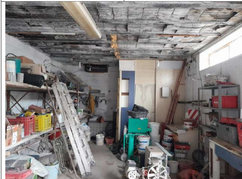
Foto 4.15b. – (destra): Edificio D: locale ex centrale termica
