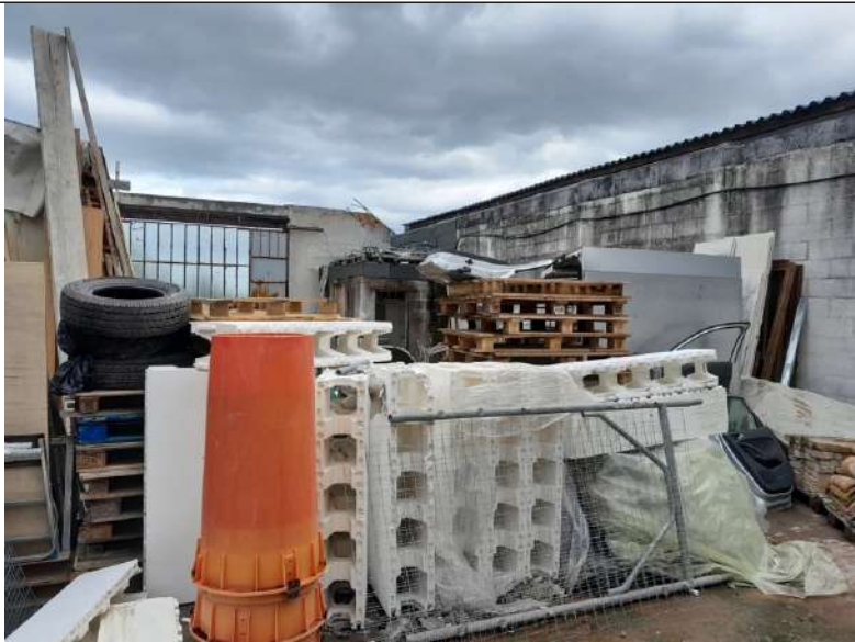
Foto 4.20. – Edificio B (privo di copertura): interno
