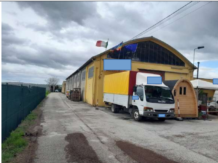
Foto 1.02. – Fabbricato di cui alla part. 159 e viabilità interna degli spazi scoperti di pertinenza.
