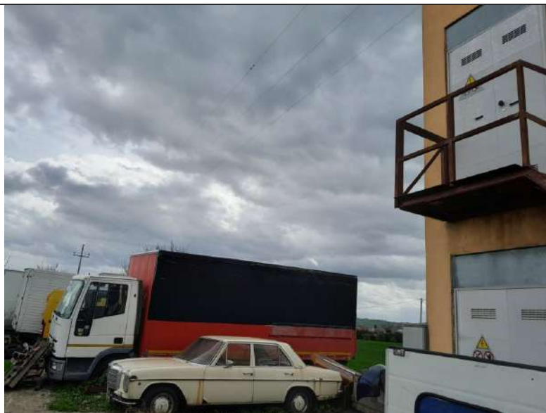
Foto 1.10. – Scoperto di pertinenza esclusivo del fabbricato (opificio), sul retro, nei pressi fabbricato adibito a cabina elettrica di media tensione in servizio.
