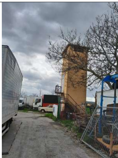
Foto 1.09. – (a sinistra): fabbricato adibito a cabina elettrica di media tensione in servizio.
