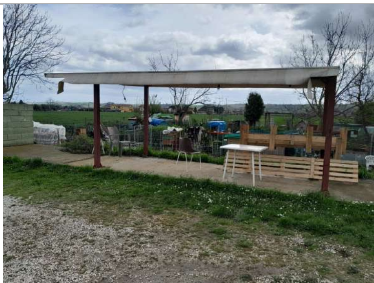
Foto 1.16. – (Ex) terreno agricolo sul retro corrispondenti alla particella 397 per la maggior parte trasformata in orti di piccole dimensioni: tettoia priva di legittimità.
