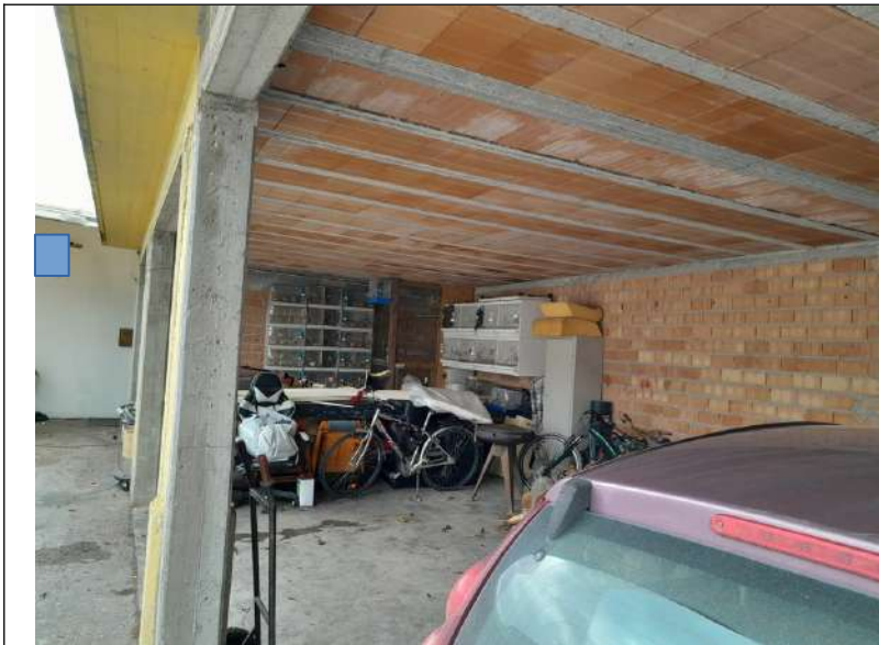
Foto 2.07. – Tettoia zona fronte
