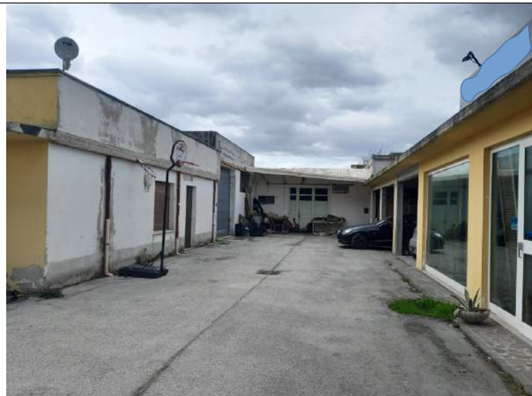
Foto 2.03. – Aree esterne limitrofe al blocco uffici sul fronte, alla tettoia e ai fabbricati produttivi sullo sfondo
