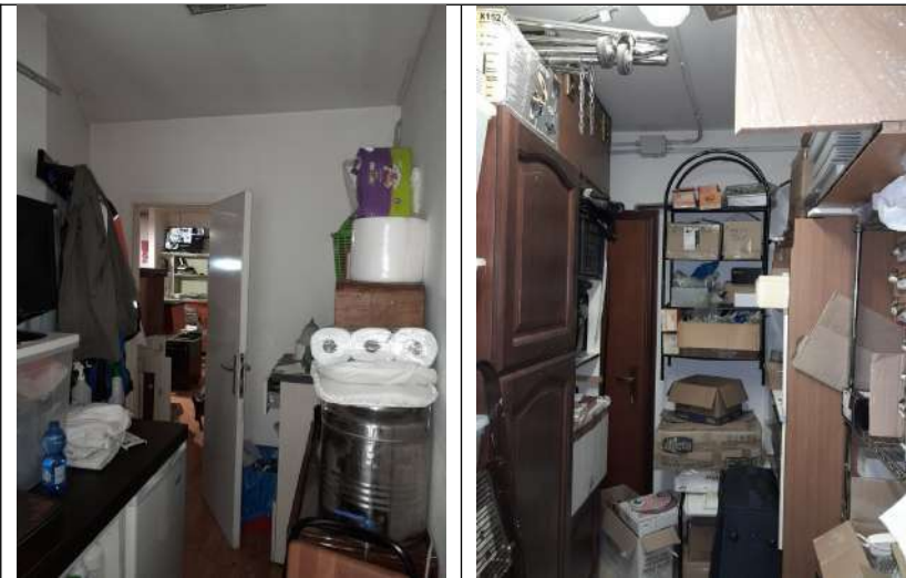
Foto 2.14. – (sinistra): Disimpegno uffici zona fronte.
