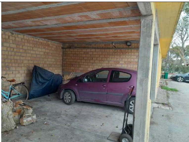
Foto 2.06. – Tettoia zona fronte
