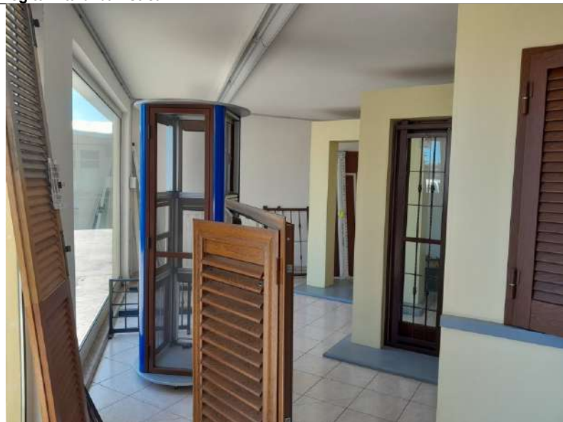
Foto 2.33. – Edificio G: sala espositiva priva di legittimità urbanistica.
