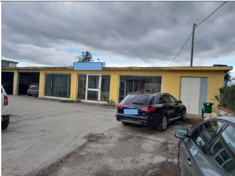
Foto 2.02. – Tettoia parzialmente tamponata e trasformata (senza titolo) in sala esposizione: esterno
