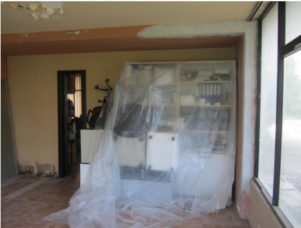
FOTO T.02_ PIANO TERRA_ufficio 1
