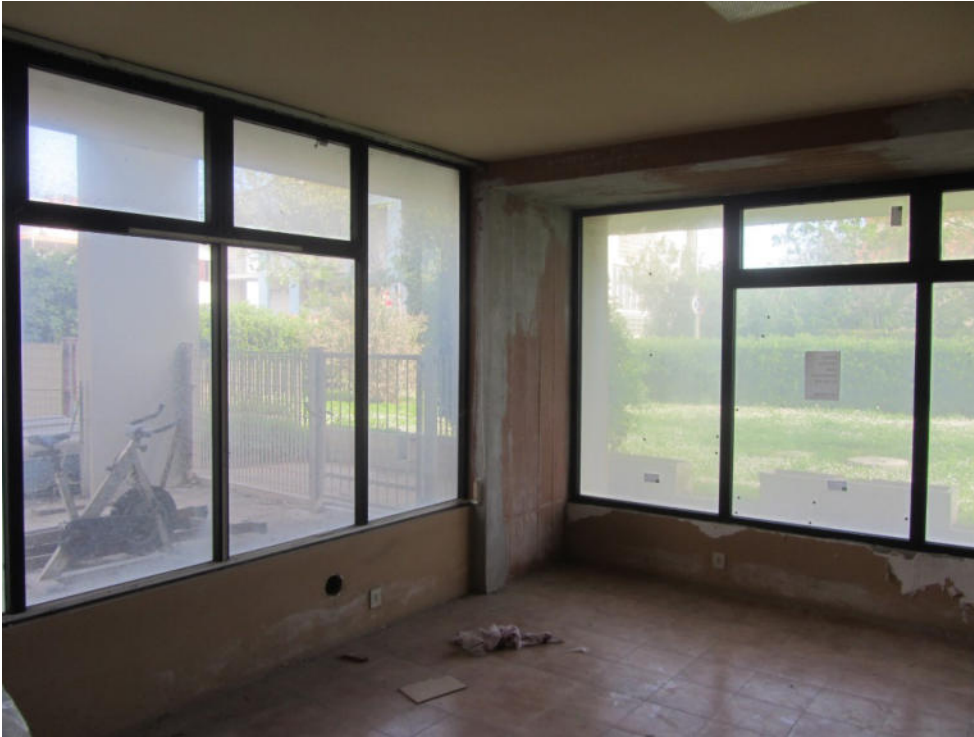
FOTO T.01_ PIANO TERRA_ufficio 1
