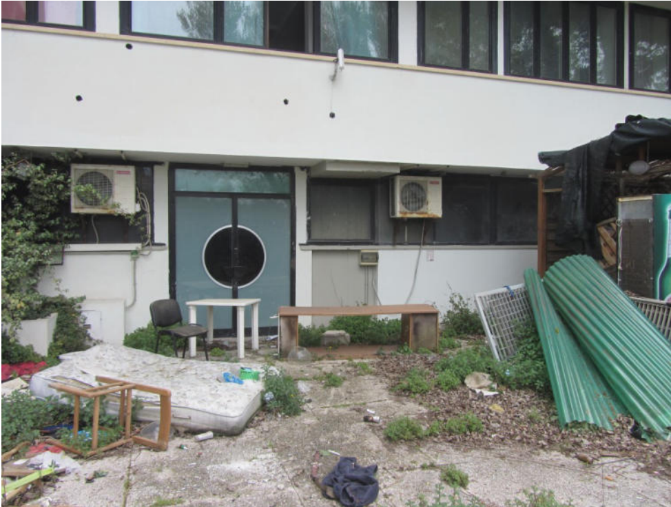
FOTO E.07_ ESTERNO_prospetto laterale
