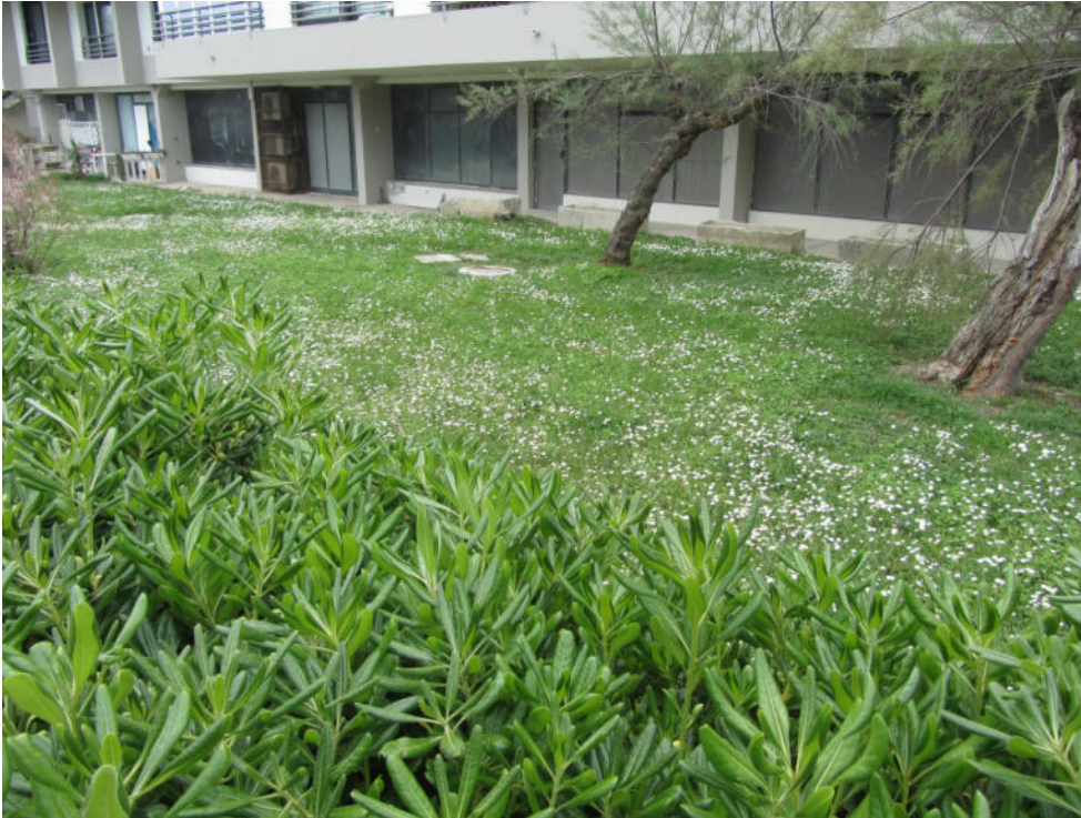
FOTO E.11_ ESTERNO_prospetto fronte
