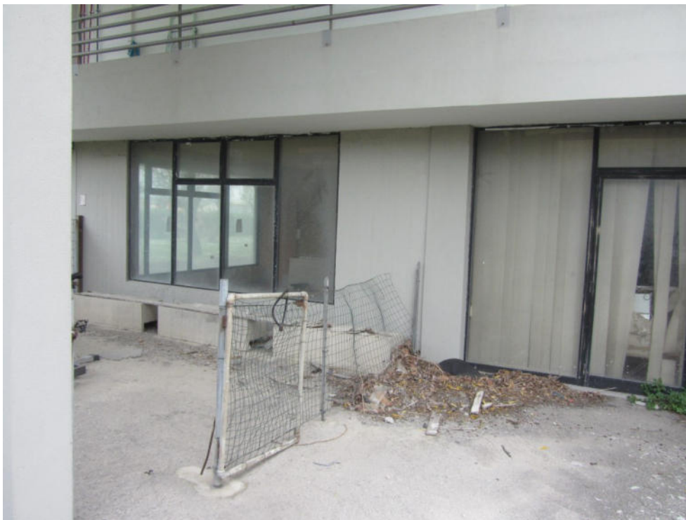
FOTO E.09_ ESTERNO_porticato
