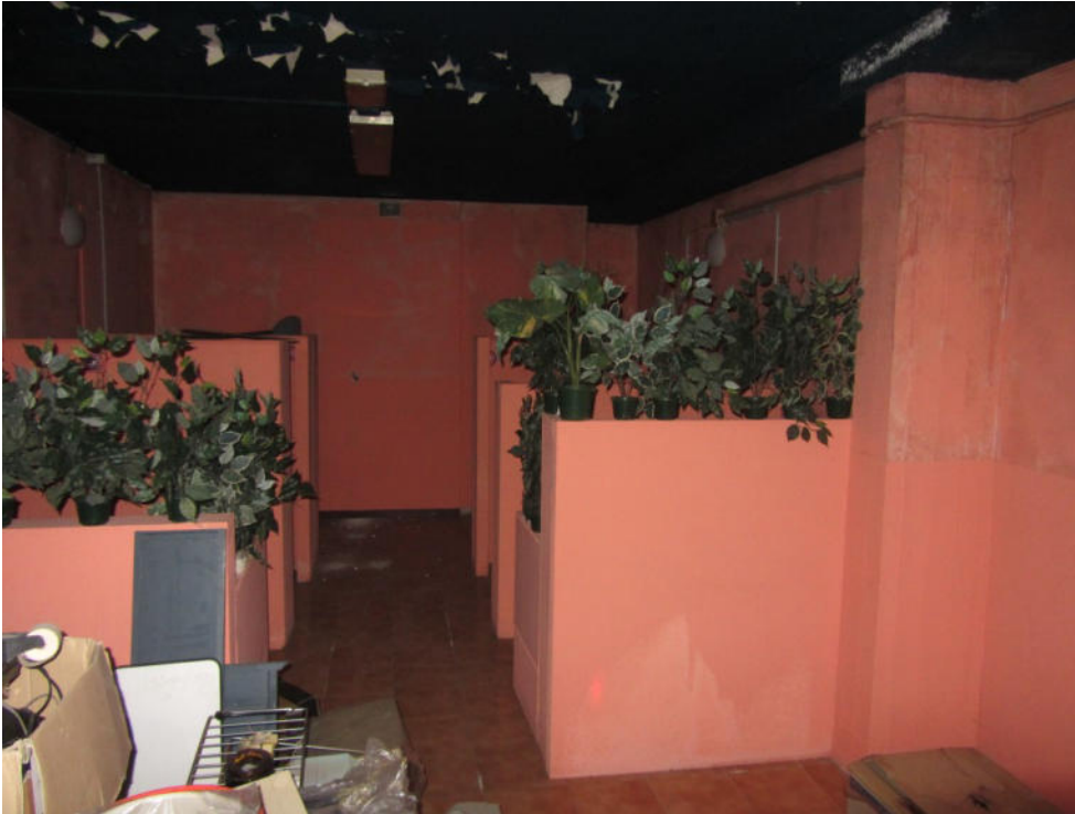
FOTO T.09_ PIANO TERRA_ufficio 2
