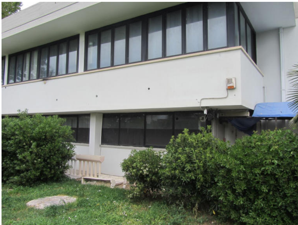
FOTO E.03_ ESTERNO_prospetto fronte
