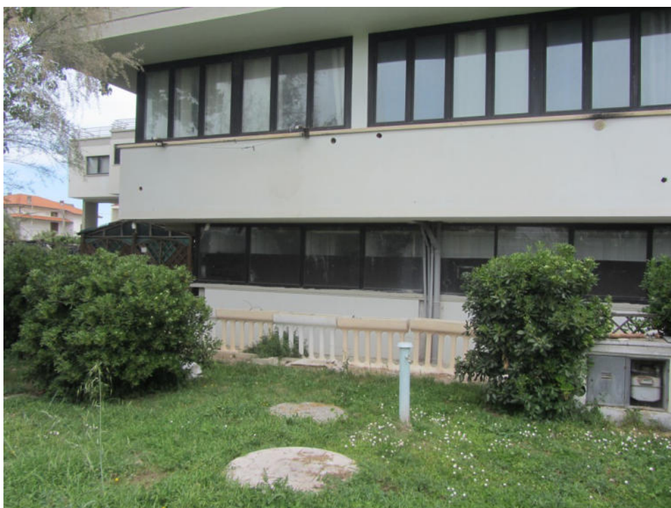
FOTO E.04_ ESTERNO_prospetto fronte
