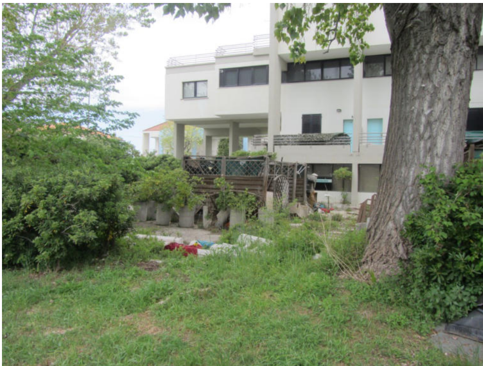
FOTO E.05_ ESTERNO_prospetto fronte
