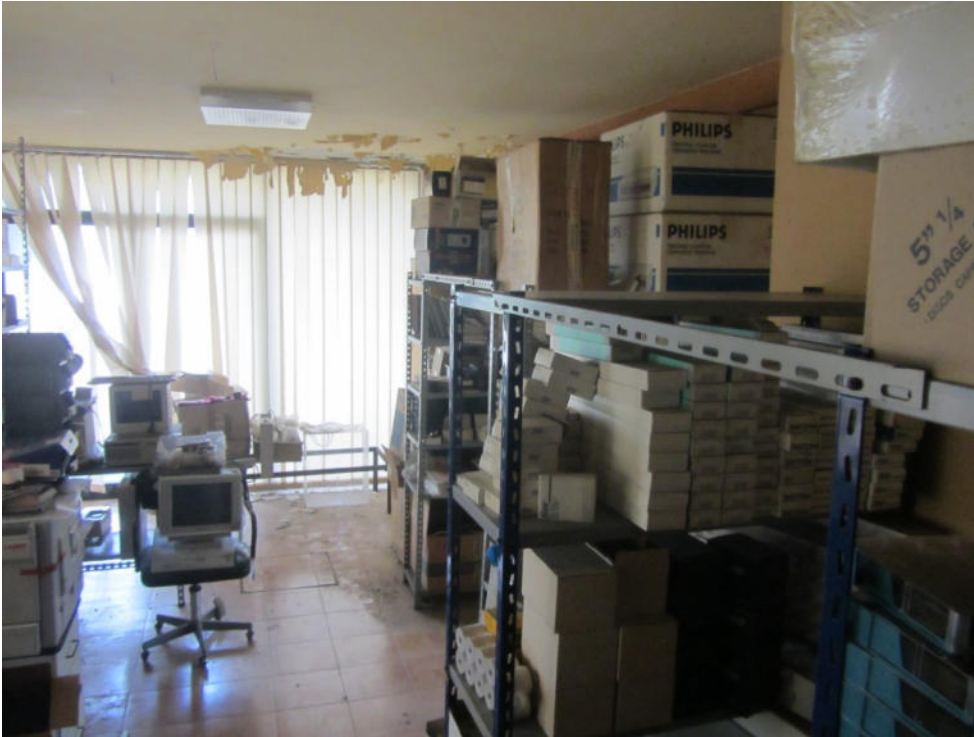
FOTO T.05_ PIANO TERRA_ufficio 1
