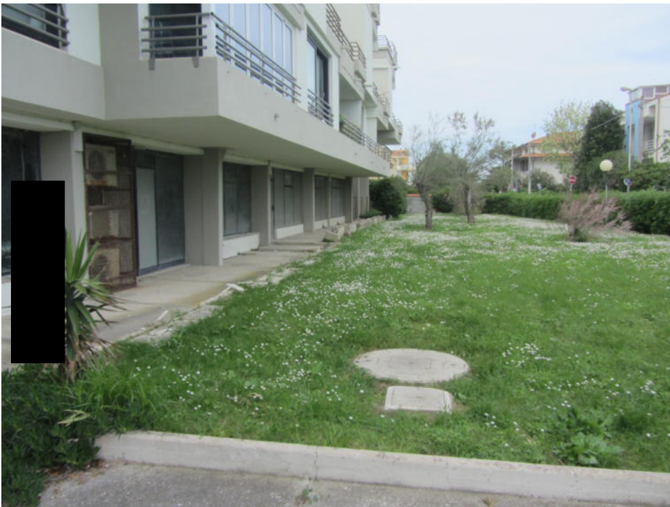
FOTO E.12_ ESTERNO_prospetto retro
