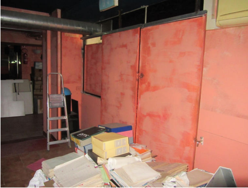
FOTO T.07_ PIANO TERRA_ufficio 2
