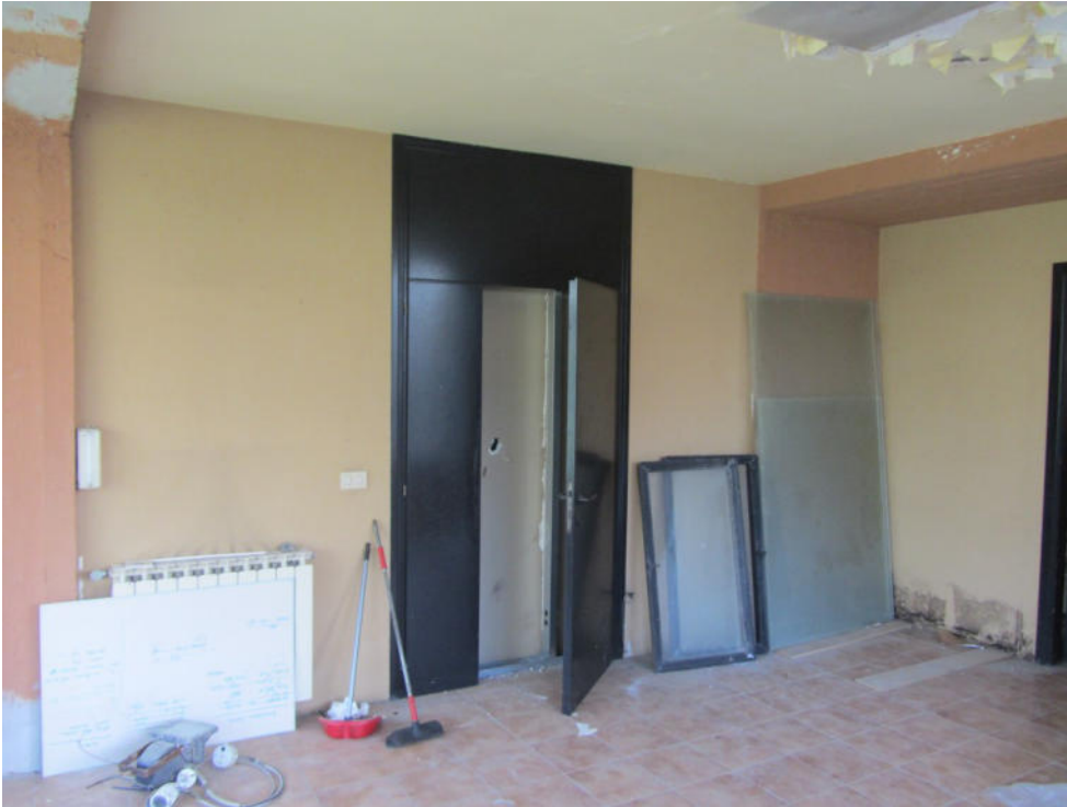
FOTO T.03_ PIANO TERRA_ufficio 1
