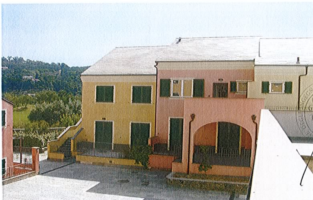
Foto n.1-19/1884 Prospetto su piazzetta interna e accesso al Lotto B6
