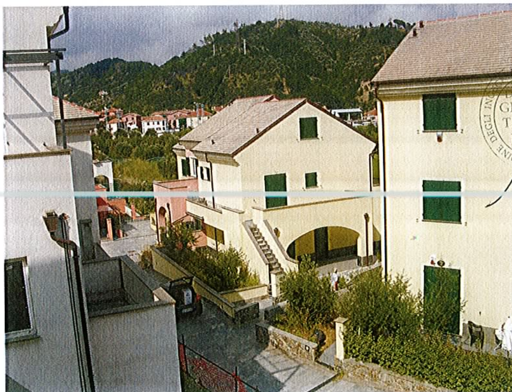
Foto n.2-19/1492 Prospetti e accesso al Lotto B5
