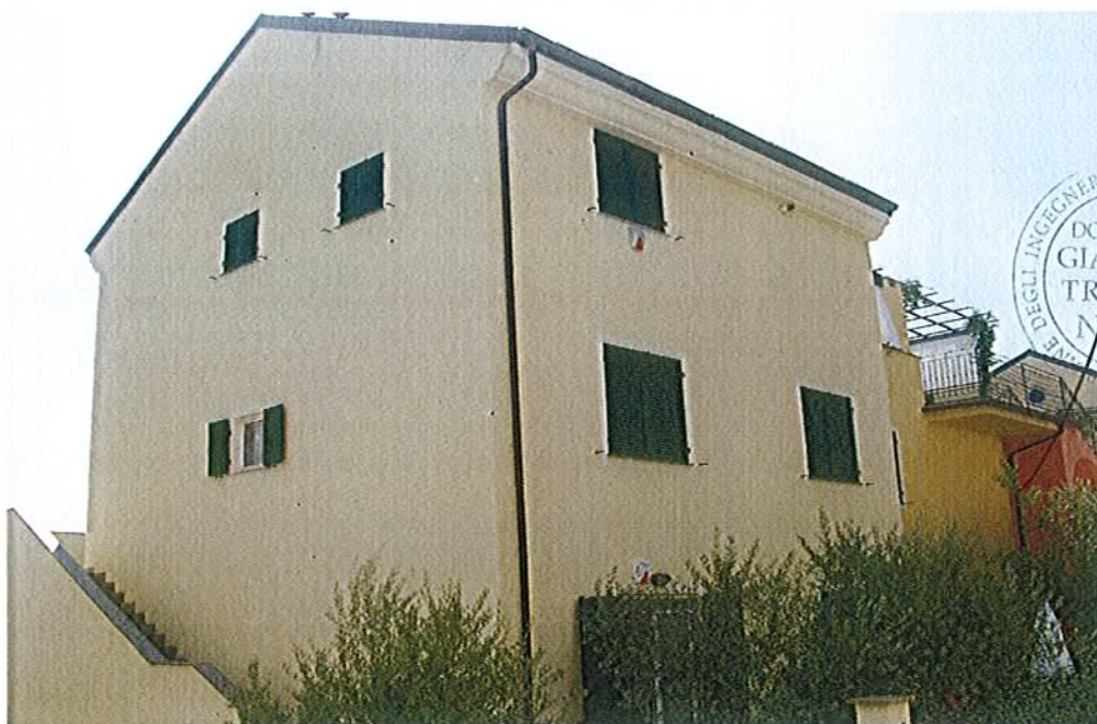
Foto n.2-16/ Prospetto su strada interna e scala accesso
