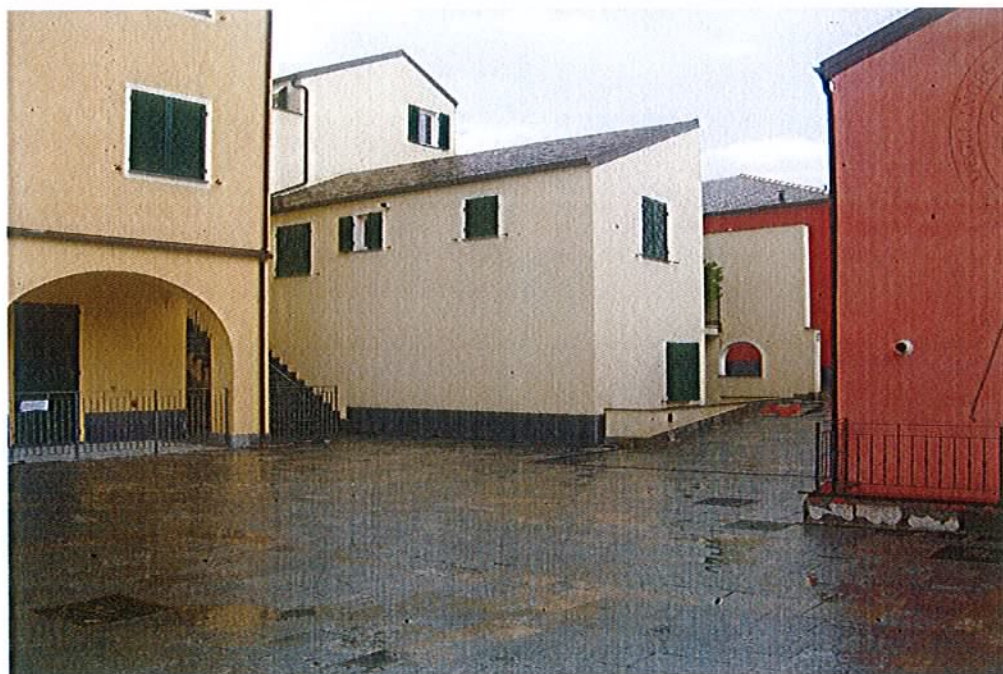
Foto n.1-3/1661 Prospetto sulla piazzetta
