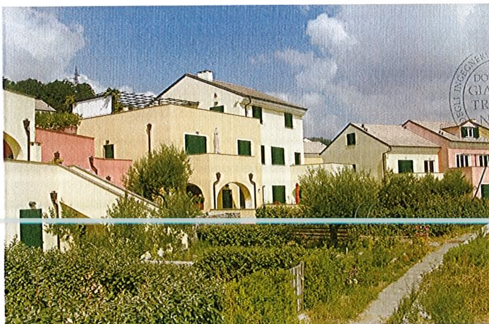
Foto n.1-16/ 1597 Prospetto su campo da golf.
