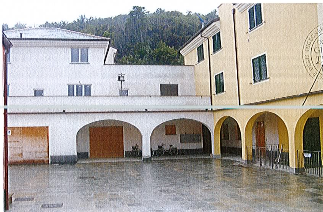
Foto n.2-20/1693 Prospetto sulla piazzetta
