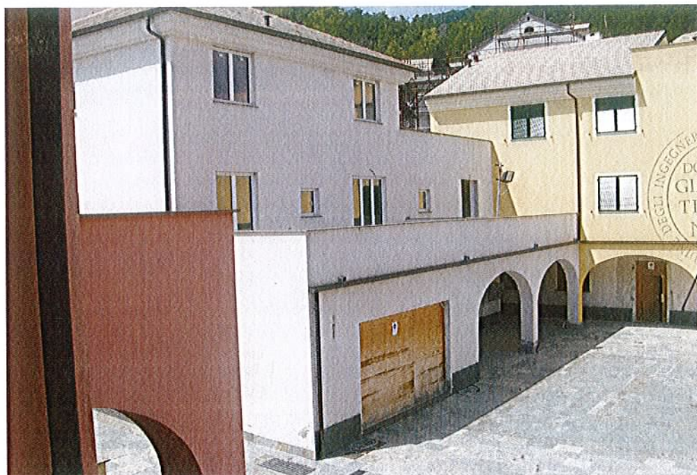
Foto n.1-20/1645 Prospetto sulla piazzetta e accesso al 20A tamponato.
