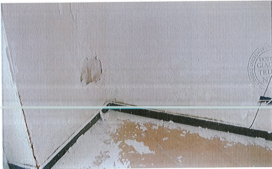
Foto n. 14-20/1890 Scrostamento tinteggiatura e intonaco.
