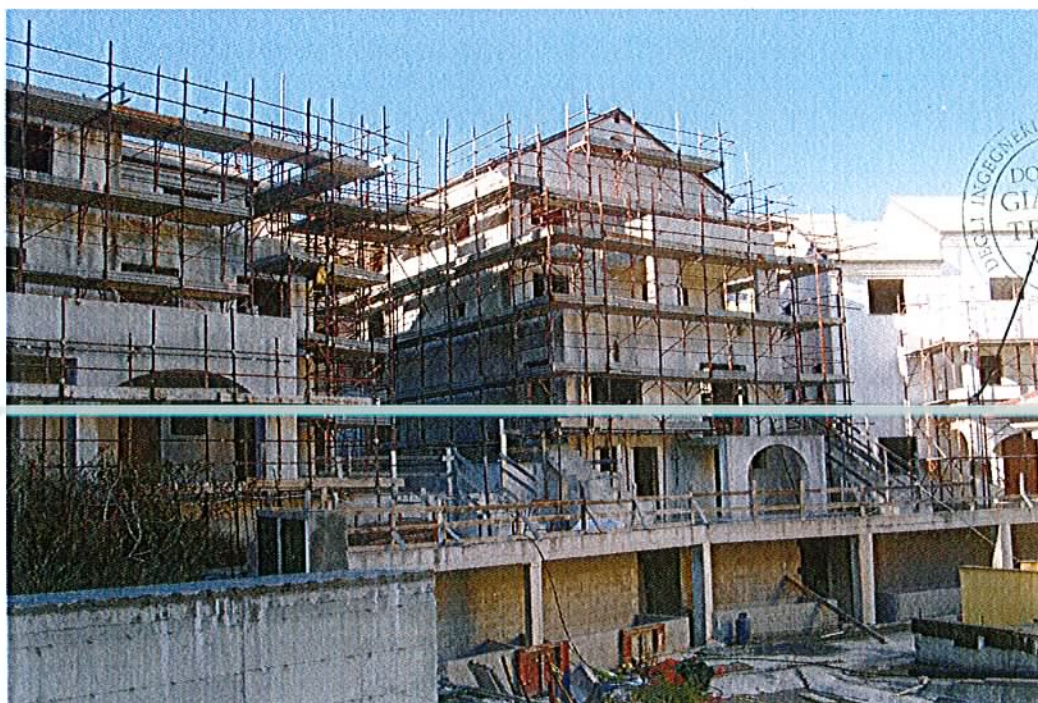
Foto n.1-35/2421 Prospetto su area cortilizia.
