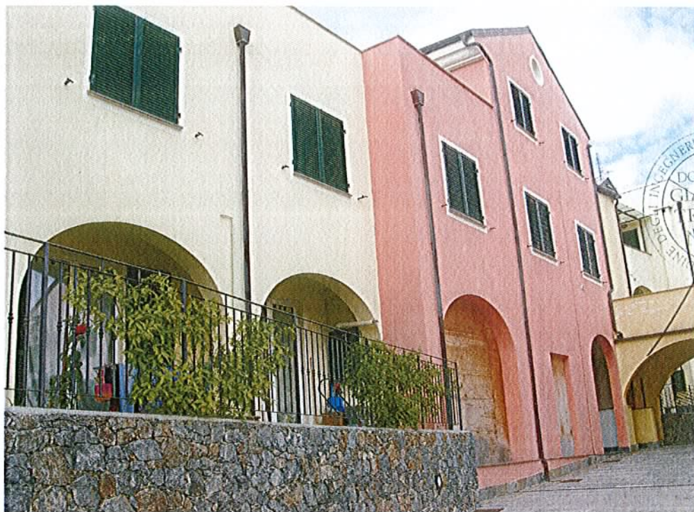
Foto n.1-33/3125 Prospetto sulla via interna
