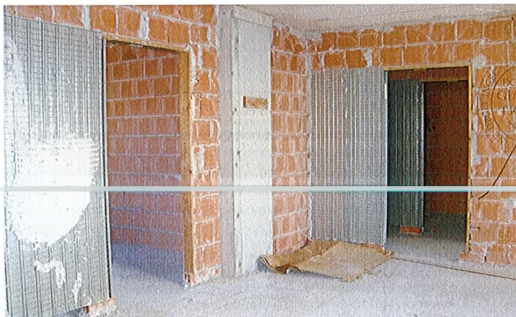
Foto n.4-34/2060 Stato opere interne.
