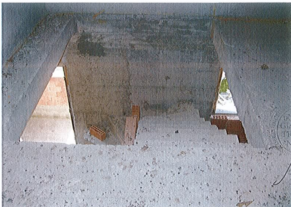
Foto n.7-34/2060 Scala di accesso al sottotetto.
