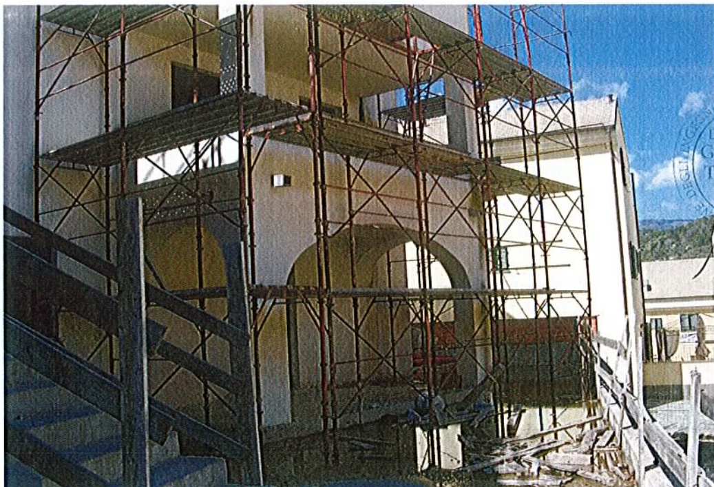
Foto n.3-34/2057 Porticato e corte di pertinenza.
