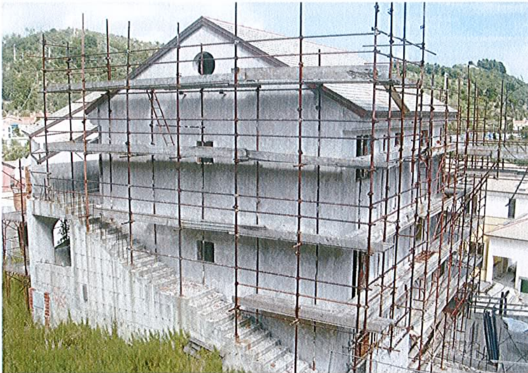
Foto n.2-35/2183 Prospetto opposto su piazzetta interna.
