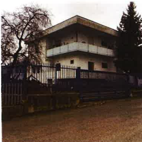
Vista esterna palazzina
