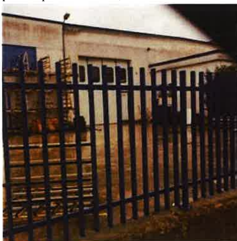
Foto esterno capannone
