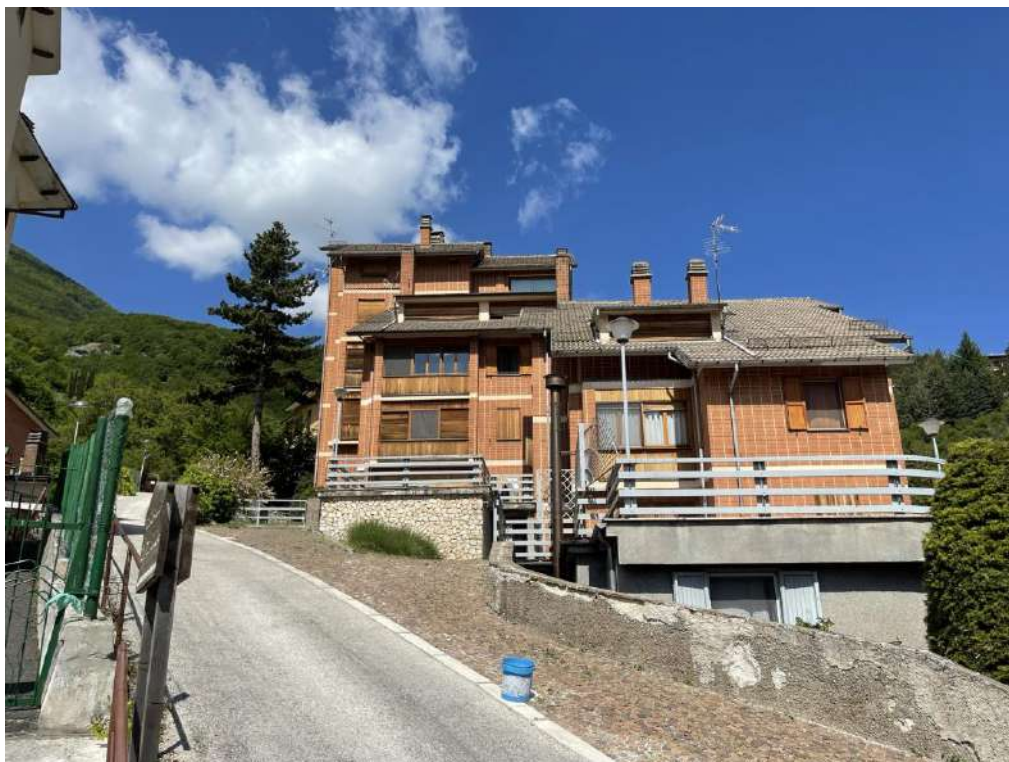
- vista dell'immobile fronte laterale (da Via Domenico Di Rienzo)
