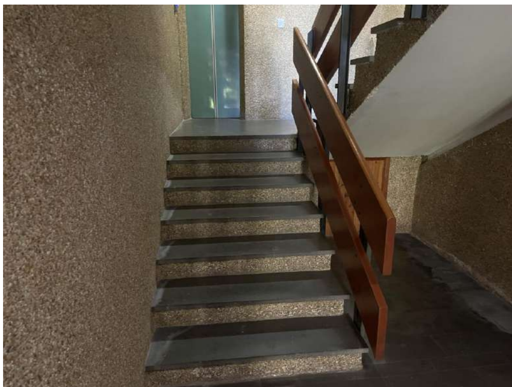
- vano scala/ascensore condominiale
