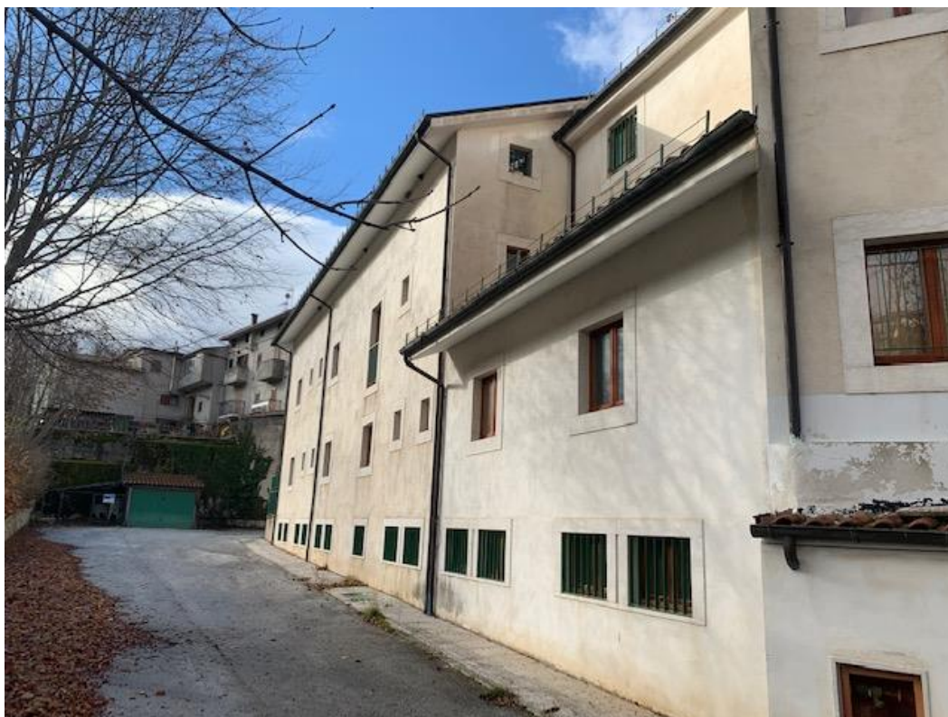
- vista laterale dell'immobile (lato est)
