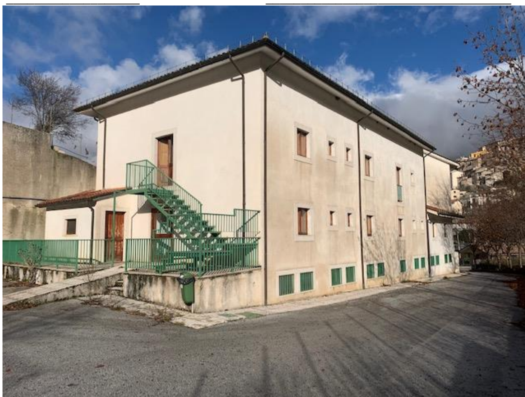
- vista posteriore dell'immobile (lato sud)
