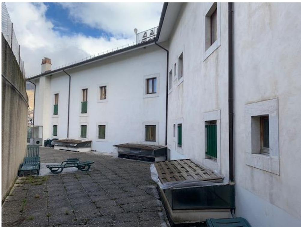
- vista laterale dell'immobile (lato ovest)
