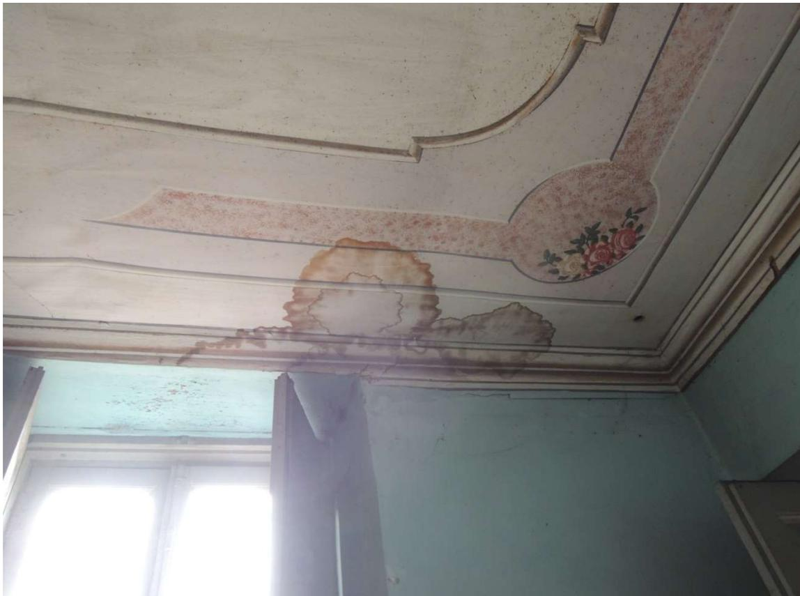
**Figura 18** Particolare infiltrazione solaio\_Vano 3
