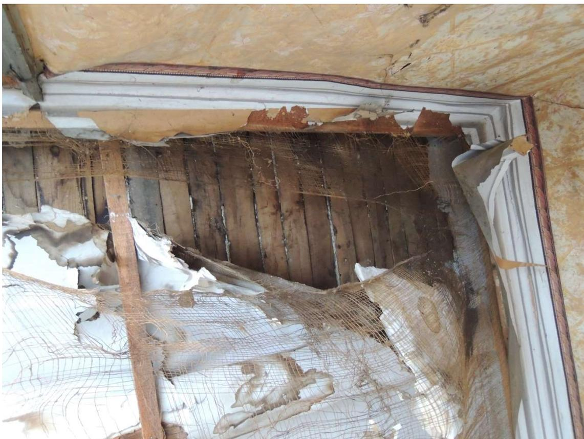
**Figura 11** Particolare condizioni del solaio\_Vano 1
