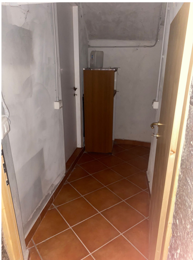
Foto n° 9 – Particolare del piano seminterrato
