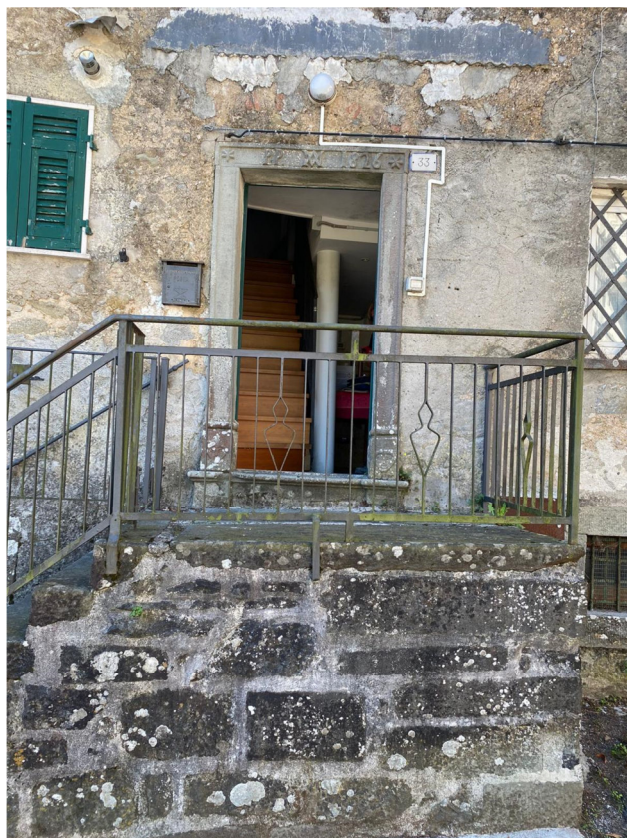
Foto n. 5 - Particolare dell'accesso all'abitazione a piano rialzato
