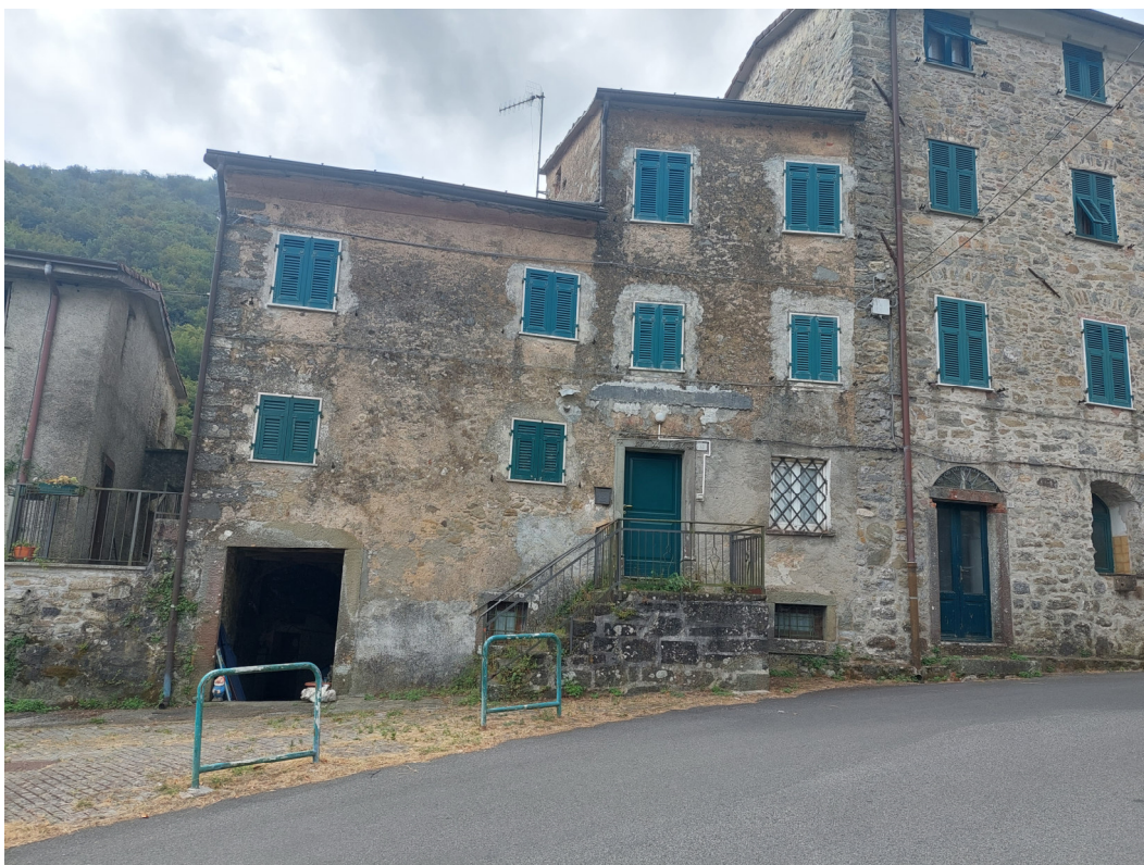
Foto n°2 – Prospetto principale su Via Maestra
