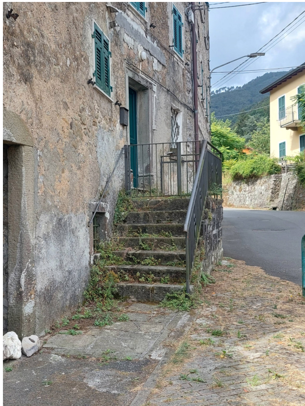
Foto n° 4 – Particolare del prospetto su Via Maestra- Scala di accesso all'abitazione
