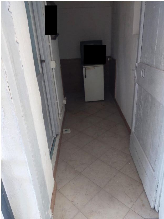
Foto n° 12 – Disimpegno di accesso al bagno – Piano secondo
