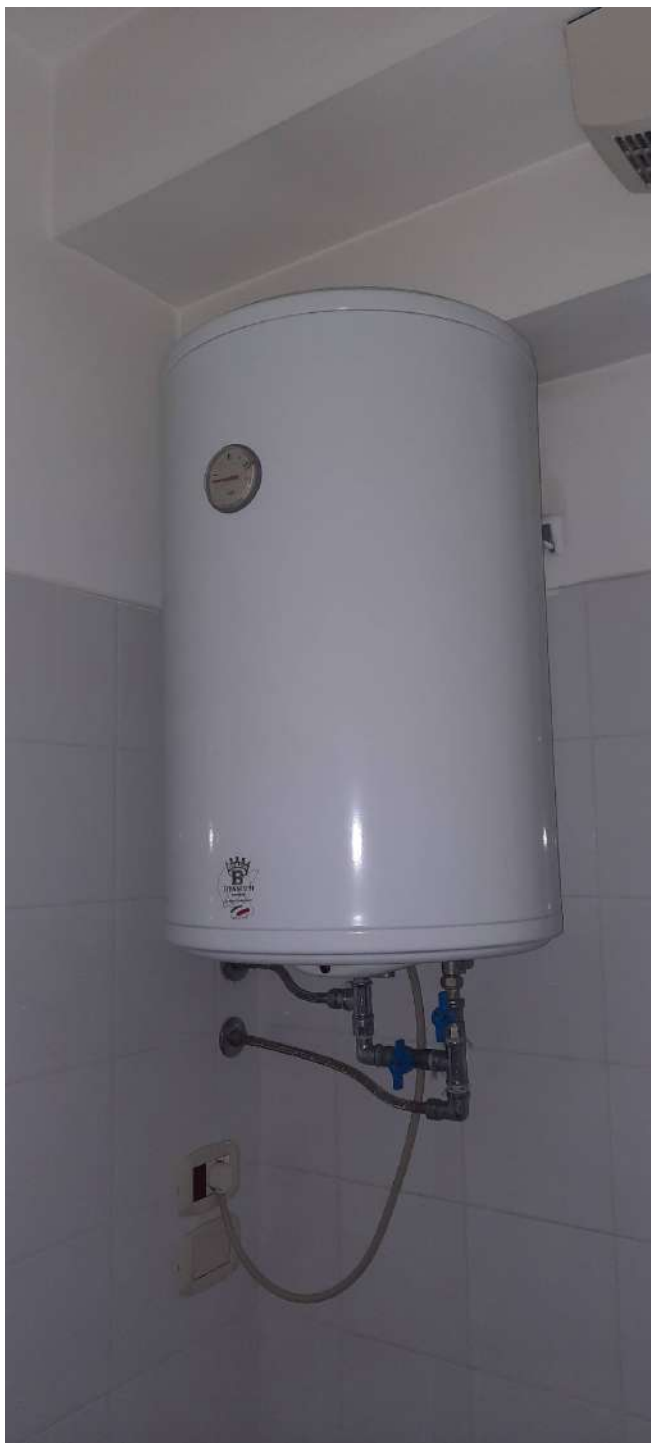
Acqua calda sanitaria (elettrico)
