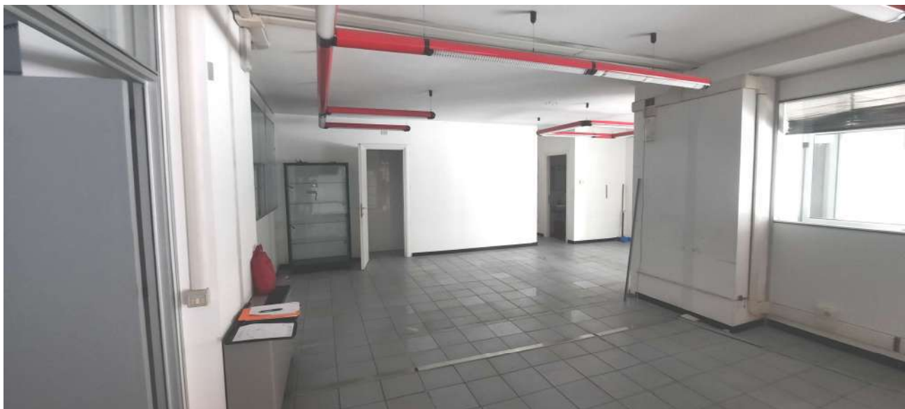
Vista locale interno
