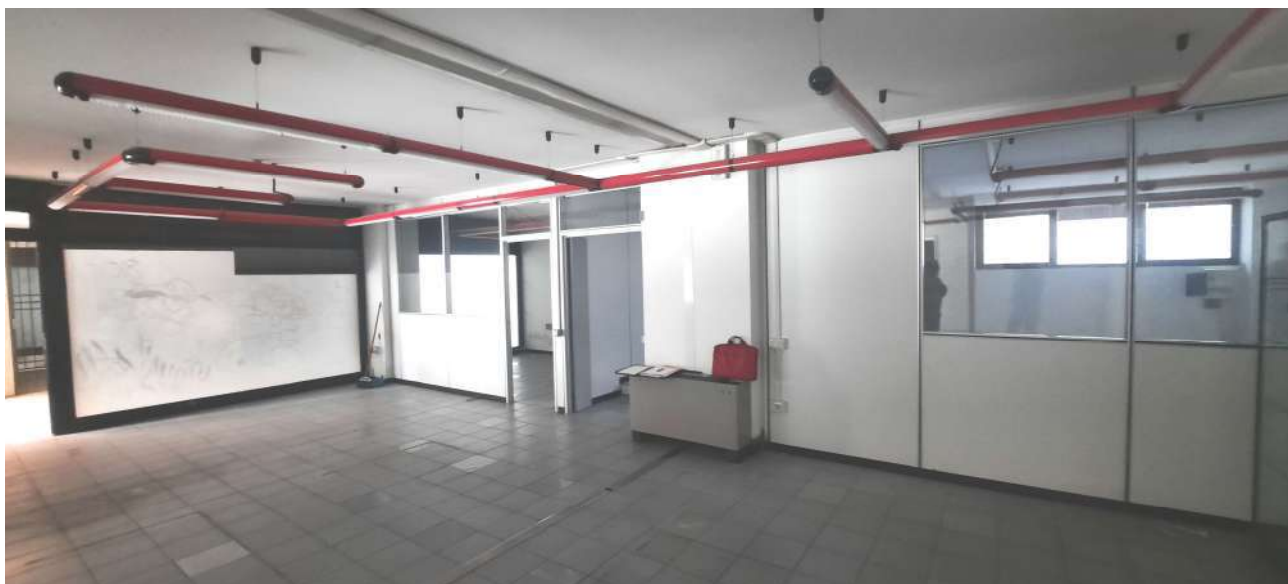
Particolare parte mobili interne ed impianto di illuminazione
