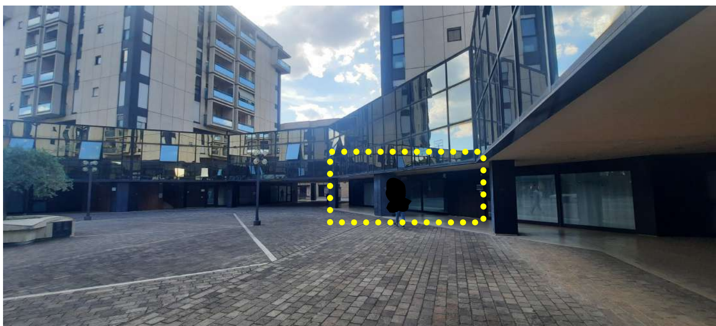
Inquadramento contesto generale dell'area condominiale circostante il negozio
