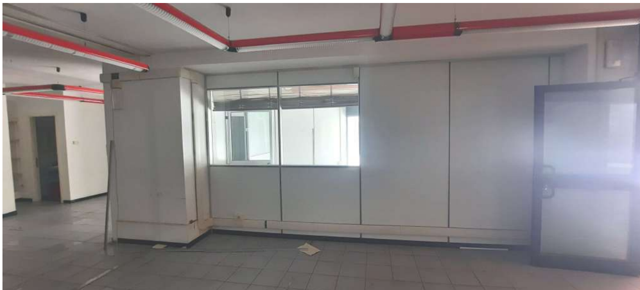
Particolare pareti mobili interne
