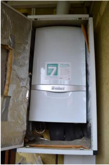
FOTO N. 13-14 – Caldaia in armadietto esterno
