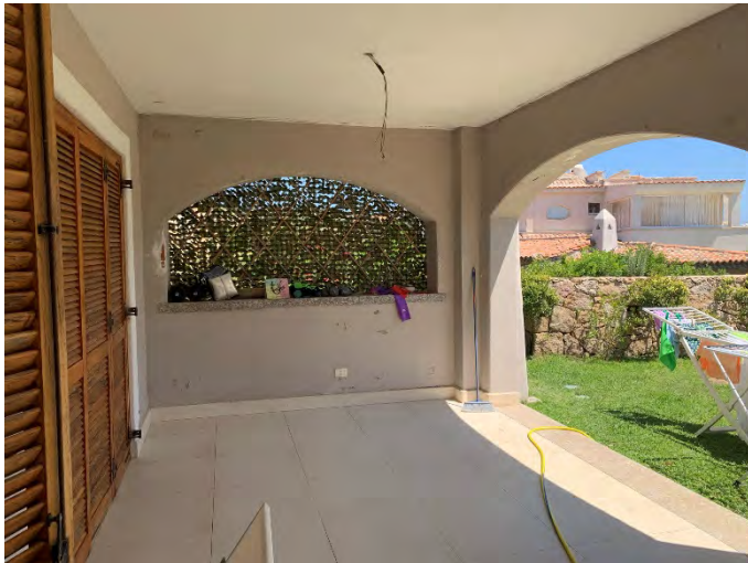
FOTO VERANDA PIANO TERRA
