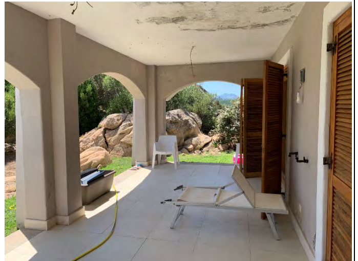
FOTO VERANDA PIANO TERRA
