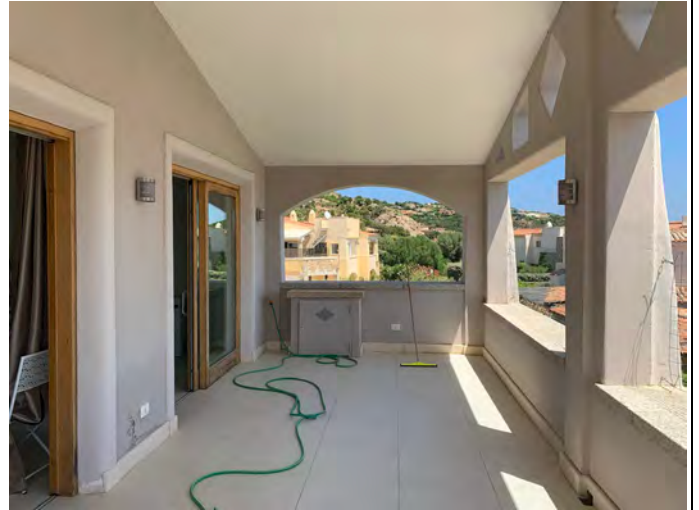
FOTO VERANDA PIANO PRIMO
