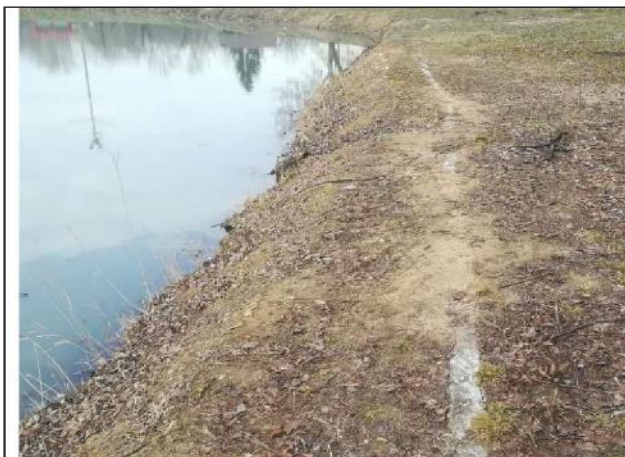
Il cordolo perimetrale lungo la sponda
