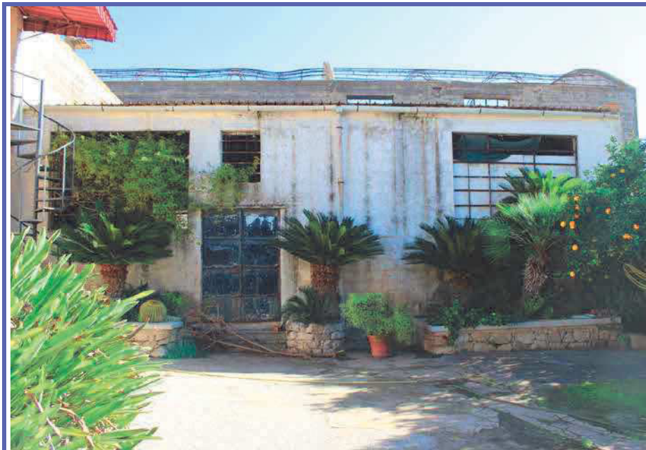
Foto 30 – prospetto su corte comune
