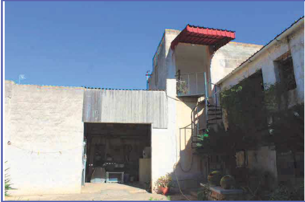
Foto 31 – ingresso deposito e scala d’accesso al 1° piano
