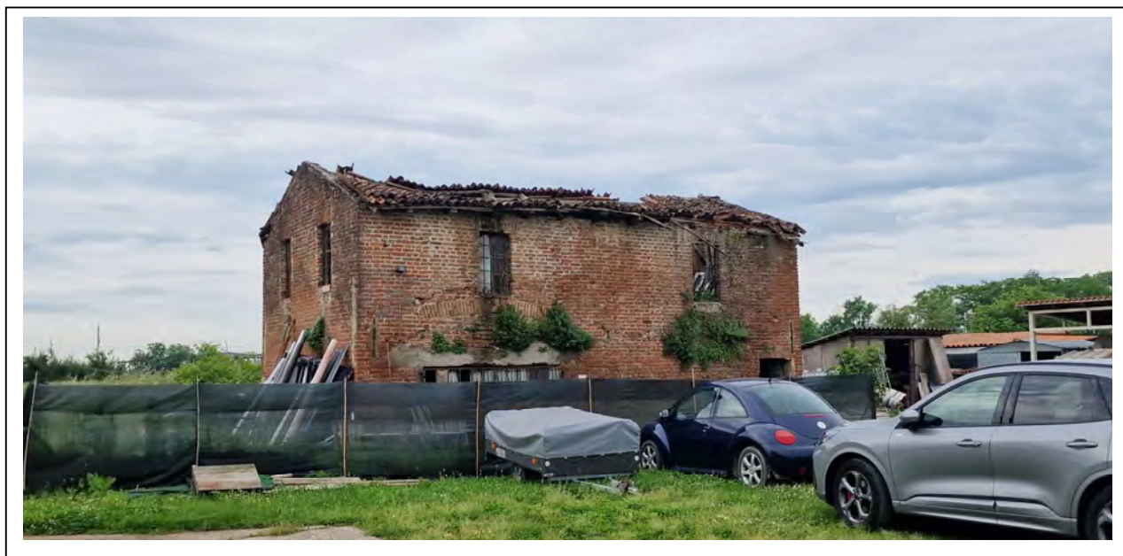
Vista del deposito dalla corte comune – fronte ovest
