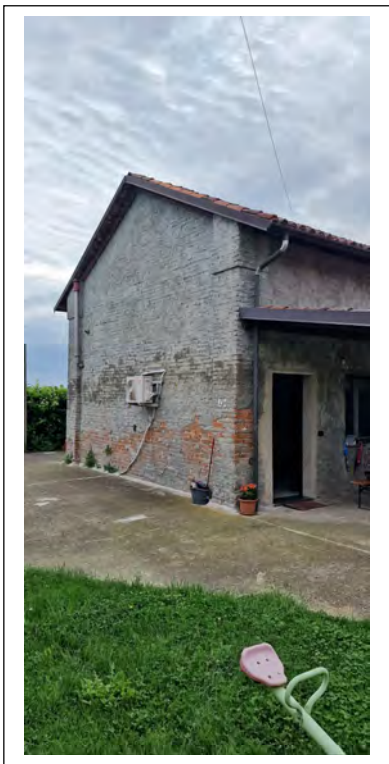
Fronte ovest. Testata abitazione
