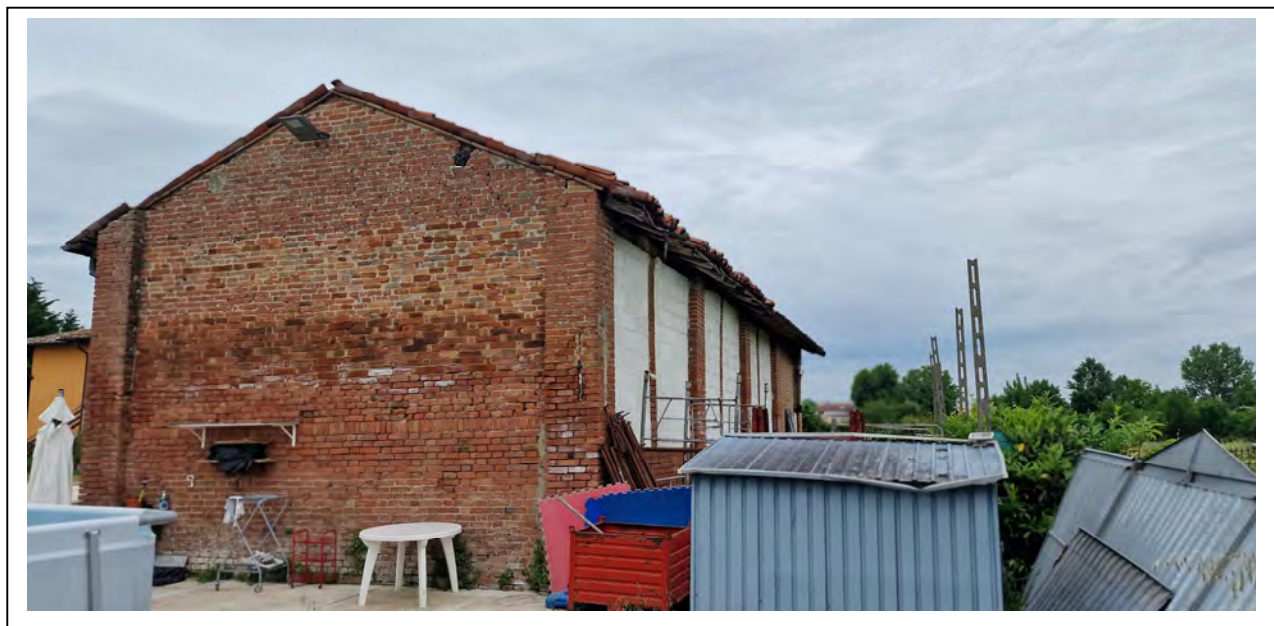
Vista del retro edificio. Fronte nord-est
