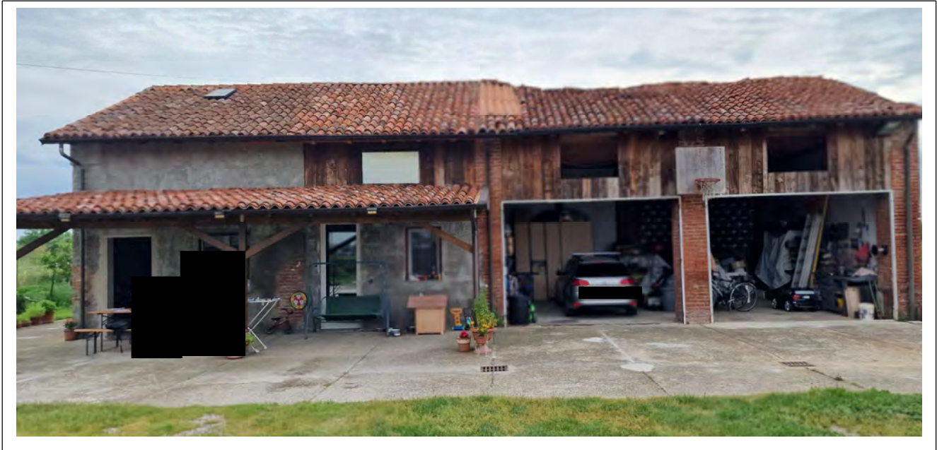
Vista sud dall'area cortilizia comune
