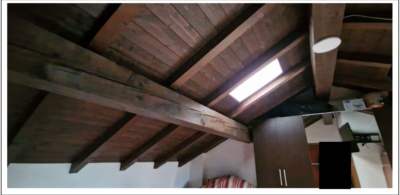
Piano Primo. Camera – struttura lignea tetto.
