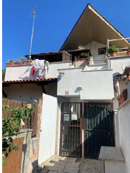
Accesso all'immobile da vialetto condominiale
