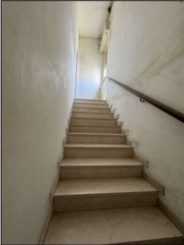
Foto 13: La scala interna.
