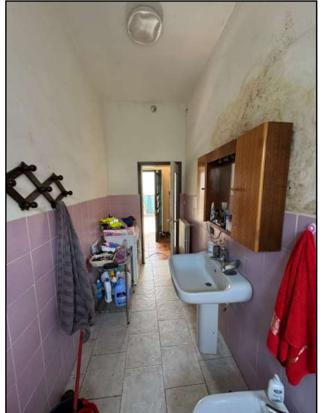
Foto 10: Il bagno al piano terreno.
