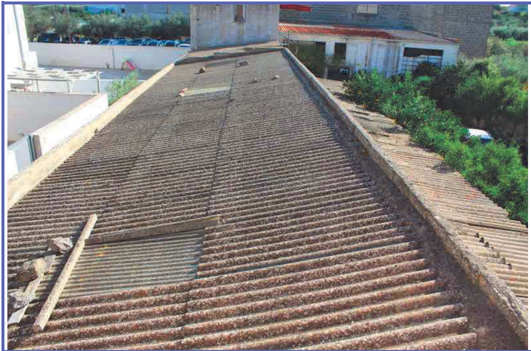
Foto 26 – copertura in cemento amianto (loc. di deposito)
