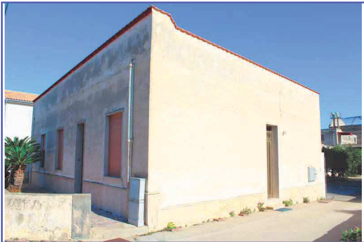
Foto 2 - prospetto su via Enrico Rinaldi
