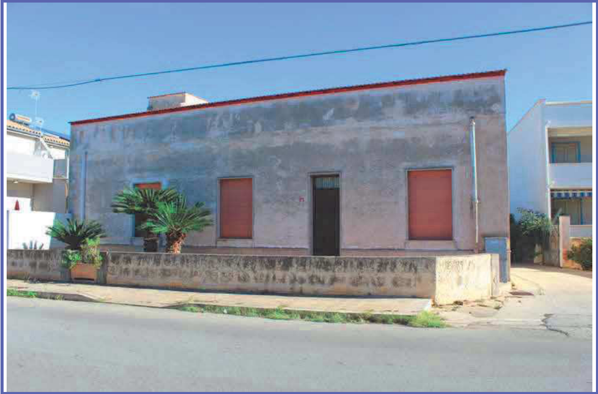
Foto 1 – prospetto su via Enrico Rinaldi
