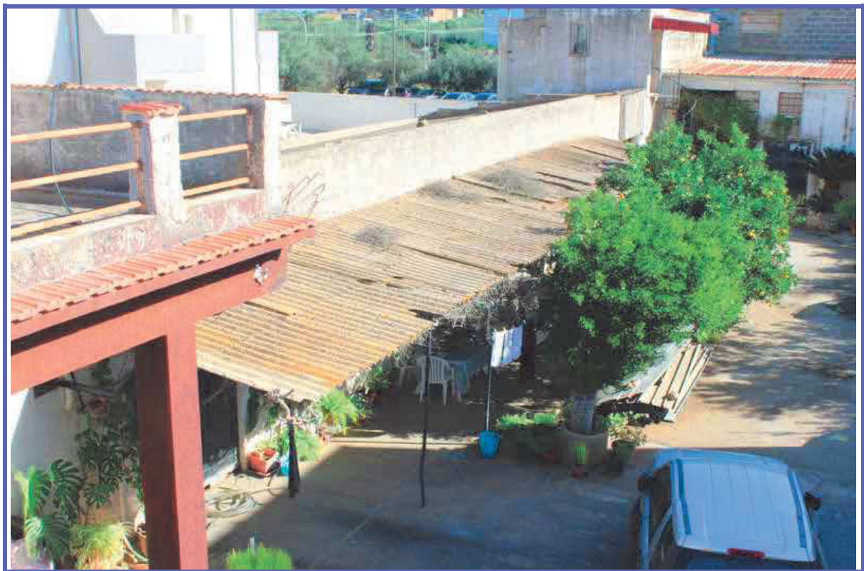
Foto 6 – tettoia in cemento amianto
