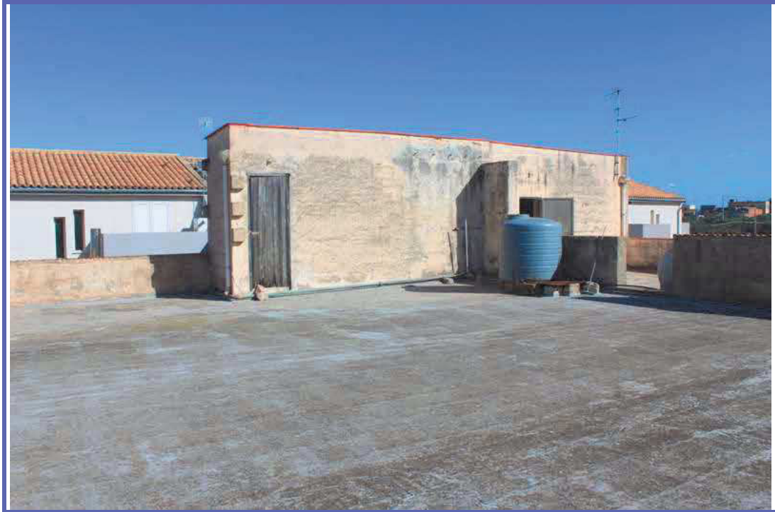
Foto 23 – terrazzo/locali di sgombero
