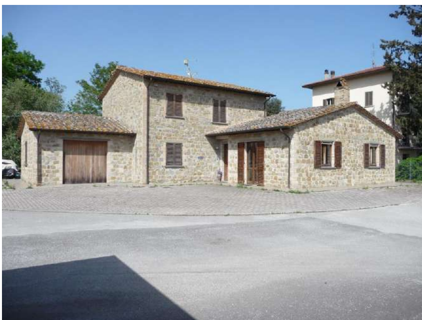
Foto n. 3 Part. 129 - Edificio fronte strada
