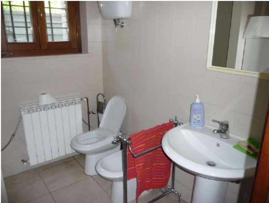
Foto n. 12 PT - Sub. 9 - Servizio igienico
