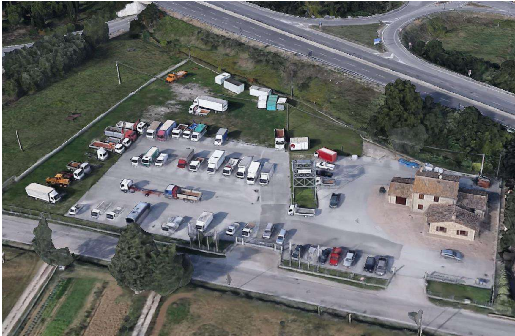
Foto n. 1 Partt. 129 e 500 - Vista aerea (da mapsgoogle)
