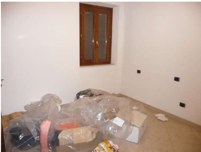
Foto n. 15 P1 - Sub. 5 - Camera
