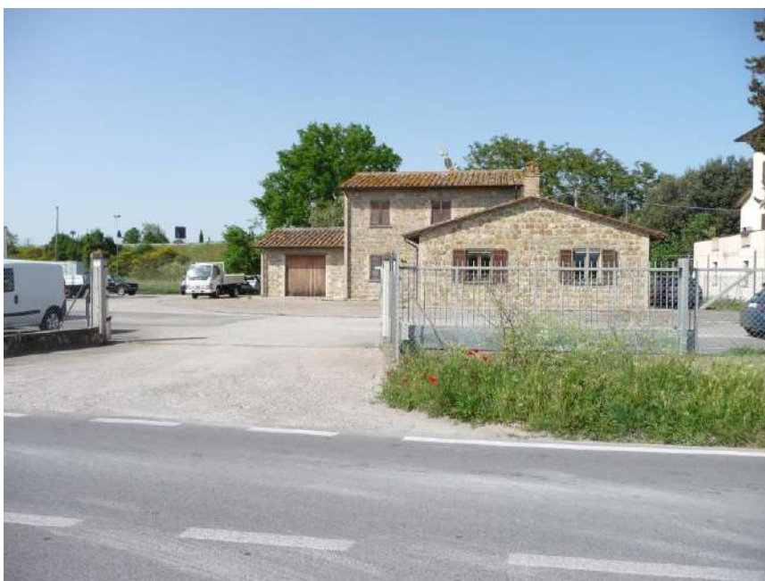
Foto n. 2 Part. 129 - Edificio con corte asfaltata da strada di accesso
