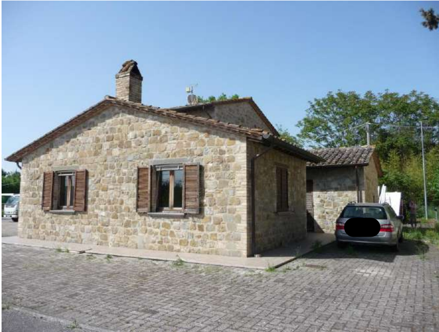
Foto n. 5 Part. 129 - Edificio fronte strada e fianco est
