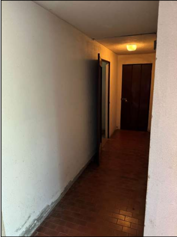
Foto 21: Il piano cantinato.
