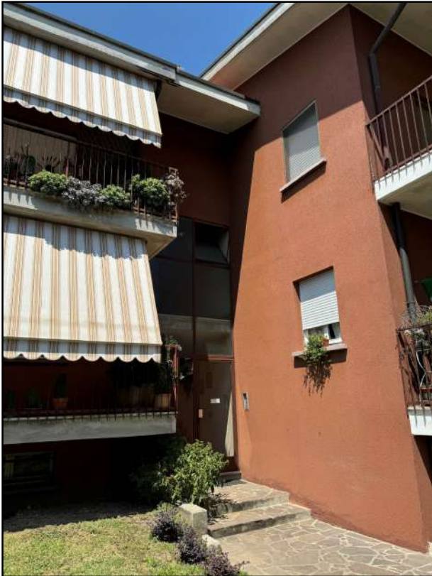
Foto 1: Prospetto del fabbricato nel quale sono inseriti gli immobili pignorati.
