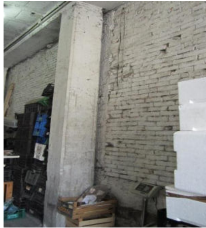
Foto 15 Interni locale magazzino-deposito
