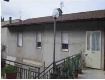
Foto 1 Abitazione foglio 58 p.la 1773 sub8
