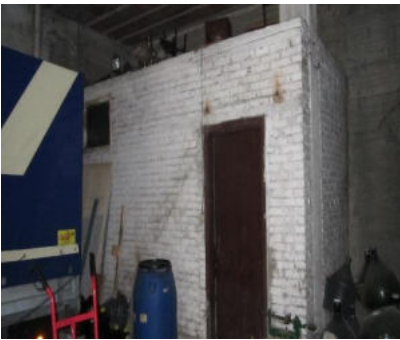
Foto 16 Interni locale magazzino- deposito
