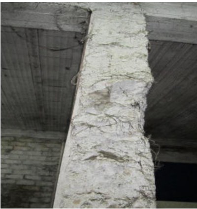
Foto 17 Interni Elementi strutturali da ristrutturare
