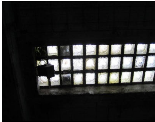
Foto 18 Lucernario terrazzo(da ristrutturare) copertura magazzino
