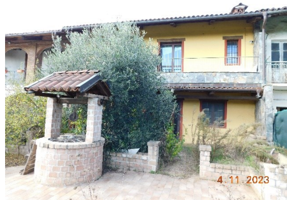
figura - vista porzione di fabbricato ad uso abitativo ed area a sud ad esso antistante
