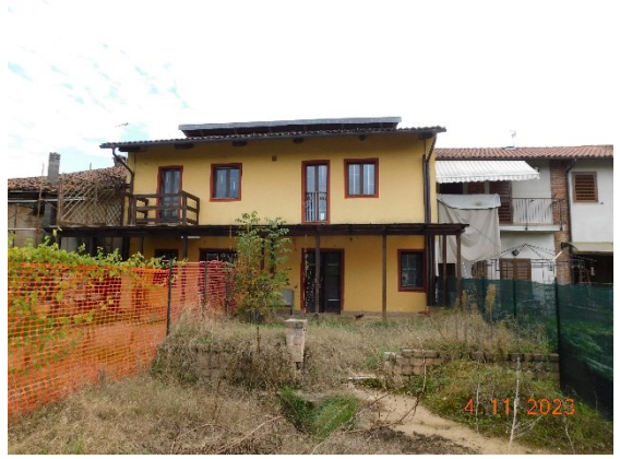
figura - vista porzione di fabbricato ad uso abitativo lato nord e area ad esso antistante
