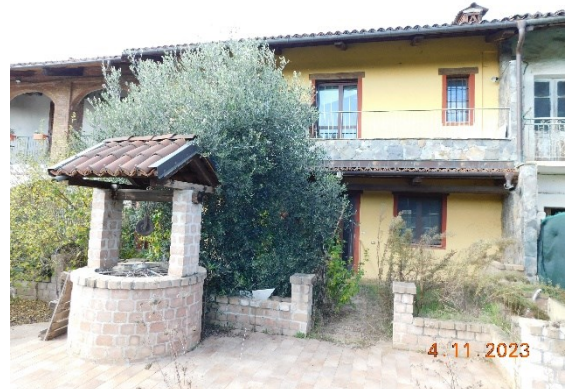
figura - vista porzione di fabbricato ad uso abitativo ed area a sud ad esso antistante
