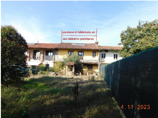
figura - vista porzione di fabbricato ad uso abitativo ed area a sud ad esso antistante
