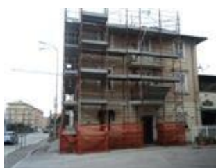
Prospetto dell'edificio residenziale su Via Ferdinando Magellano
