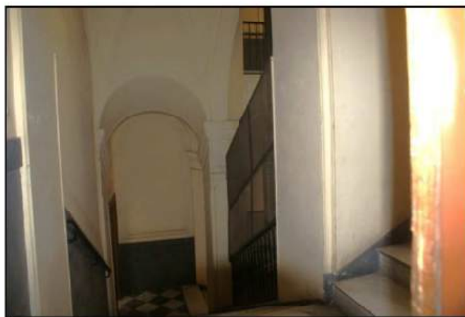
Rampa di accesso e pianerottolo tra primo e secondo piano
