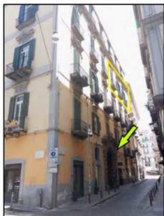
Fig. 2 Il fabbricato di via Carlo Poerio n. 110
