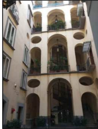
Fig.3 Il fabbricato alla Riviera di Chiaia n. 256: lo scalone sul fondo del cortile
