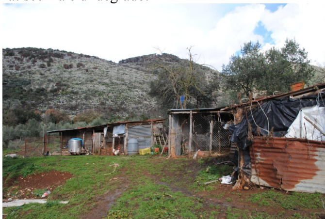
Figura 8. Altre strutture fatiscenti e precarie esistenti all'interno del centro aziendale
