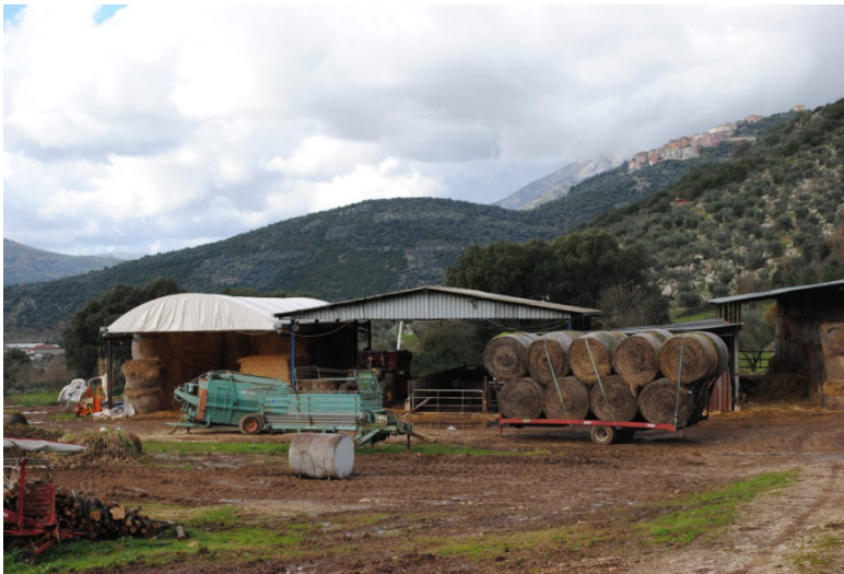
Figura 4. Prospetto a Sud della stalla a stabulazione libera e di uno dei fienili.
