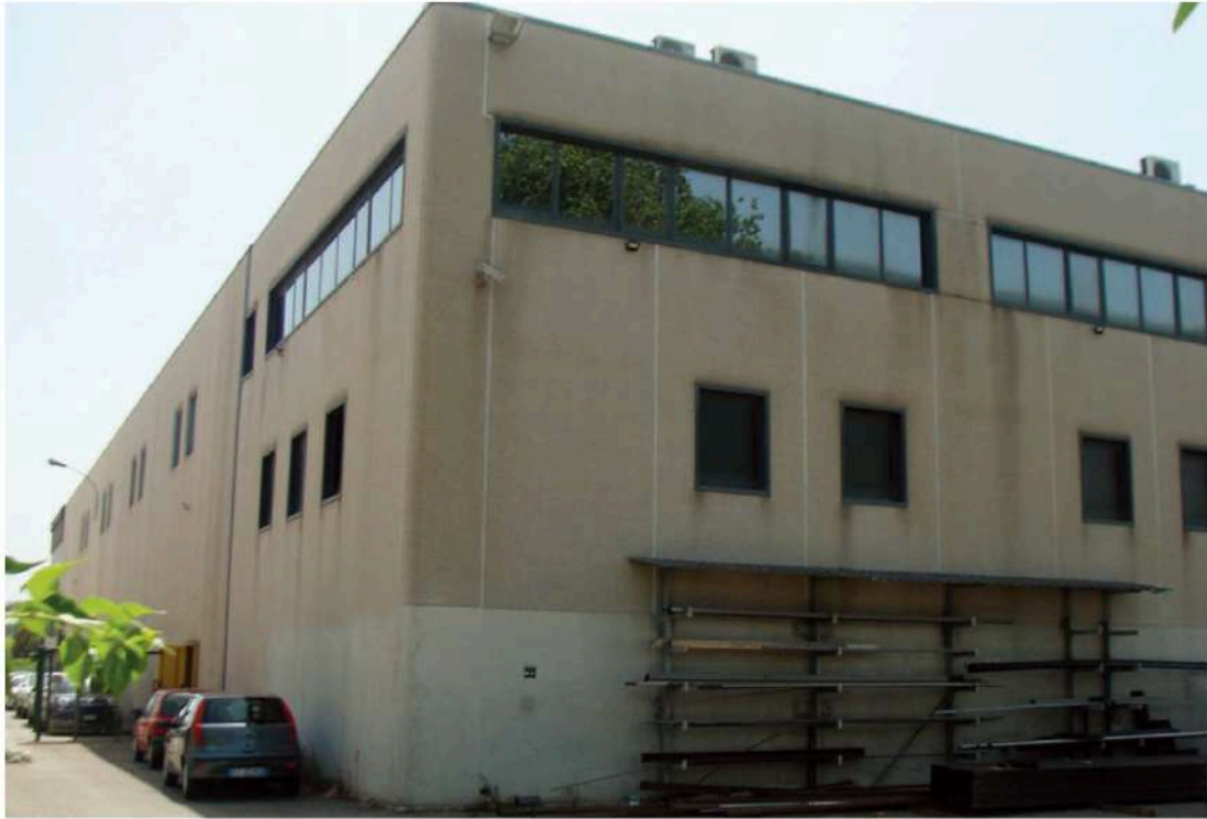
edificio facciata NORD
