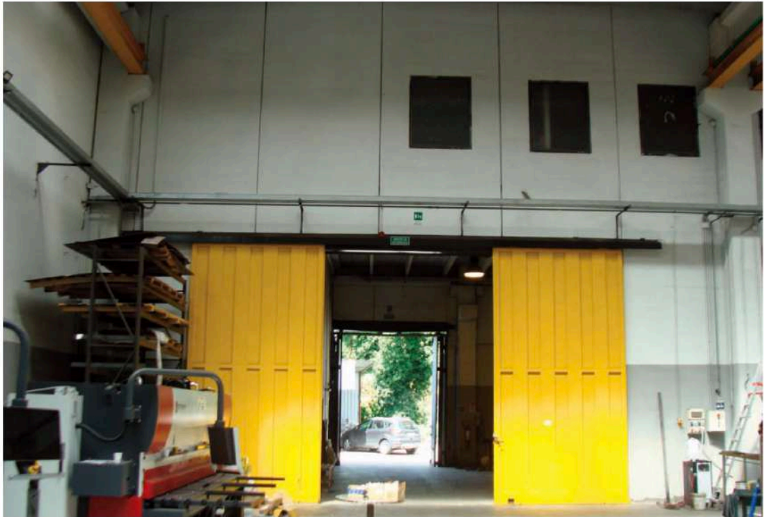
edificio facciata EST - interno (vista da particella confinante)
