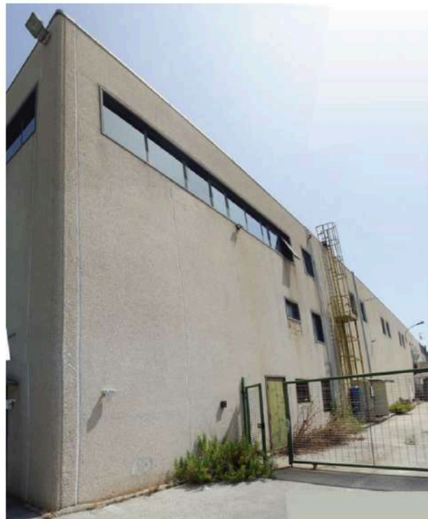
edificio facciata SUD
