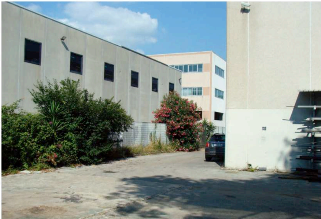
viale di accesso alla piazzola (dal lato NORD)
