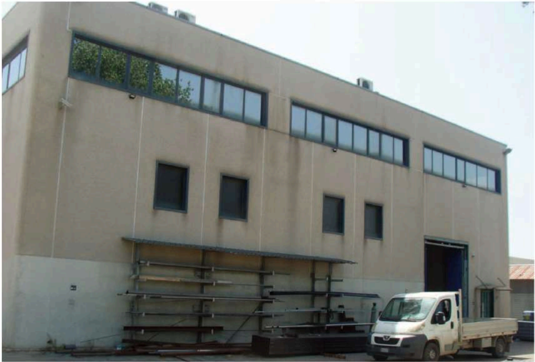
edificio facciata OVEST - esterno
