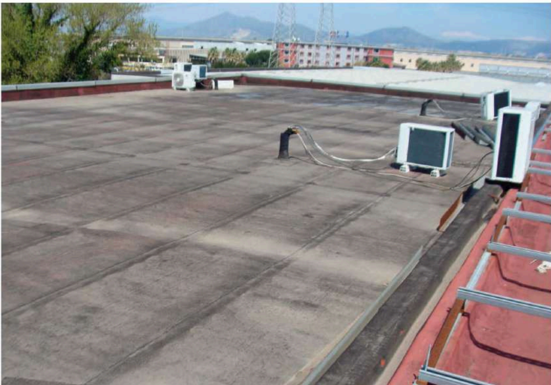
copertura (lato NORD-OVEST)
