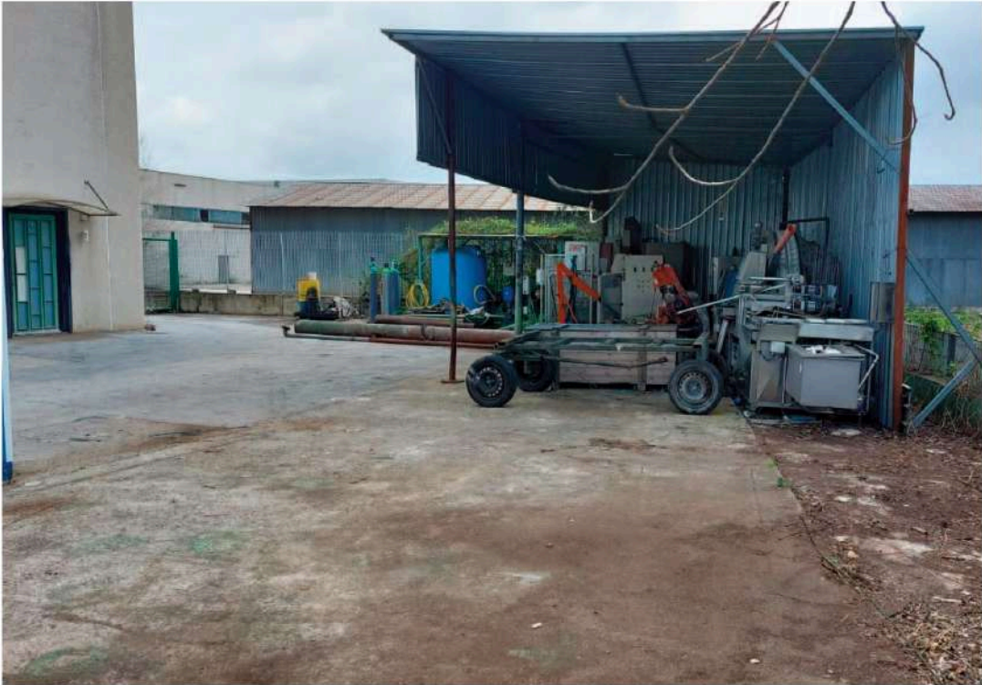
lato OVEST verso SUD (tettoia d'angolo)
