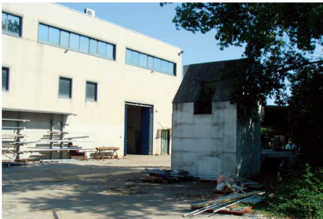
lato OVEST dalla piazzola
