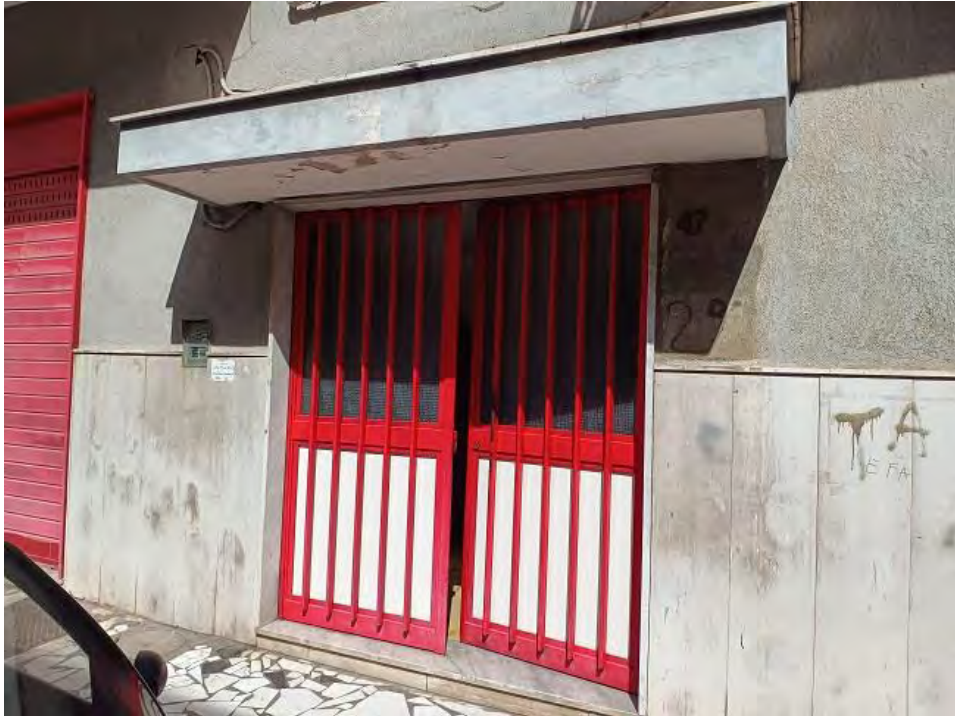
FOTO N. 29 – Porta di ingresso della cassa scala del fabbricato
