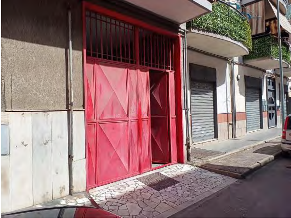
FOTO N. 37 – Portone carrabile per l'accesso al cortile del fabbricato
