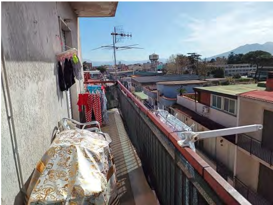
FOTO N. 36 – Balcone lato Sud
