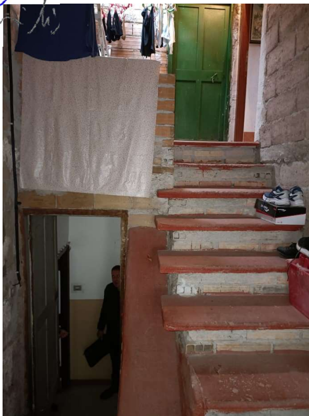
Foto 12 – Scala di accesso alle soffitte del Piano 4°
