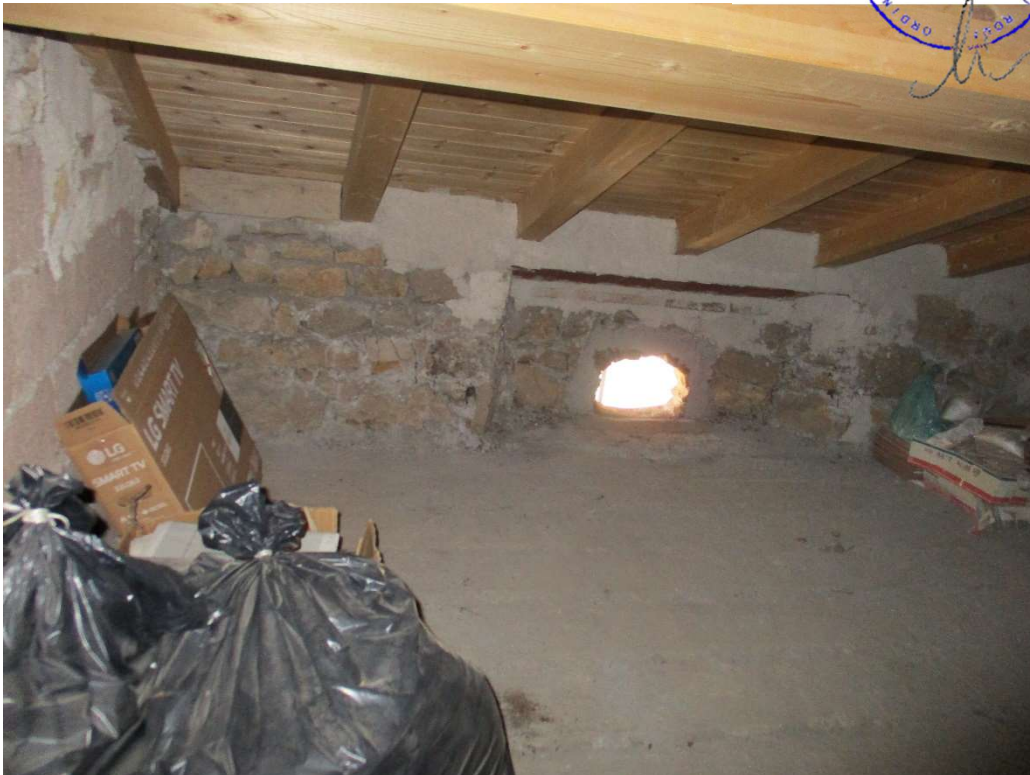
Foto 14 – Altra vista della Soffitta 2
