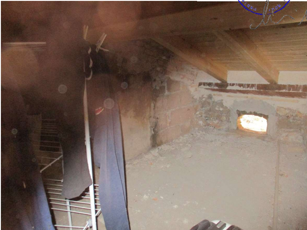
Foto 16 – Altra vista della Soffitta 1
