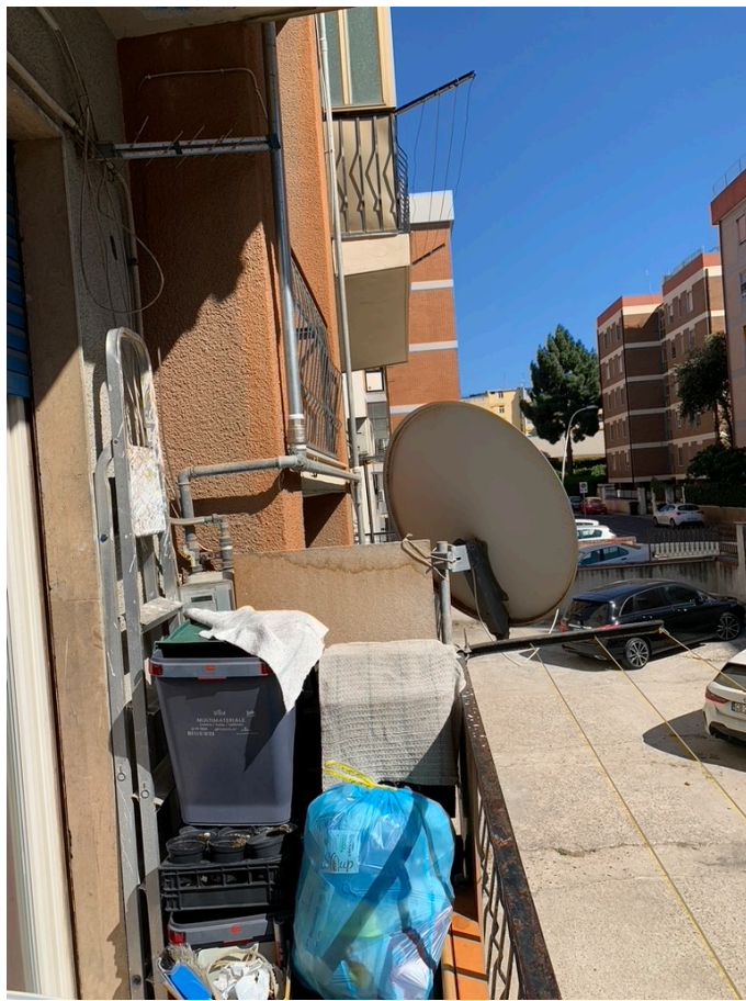
FOTO N. 15 VISTA INTERNA - BALCONE
