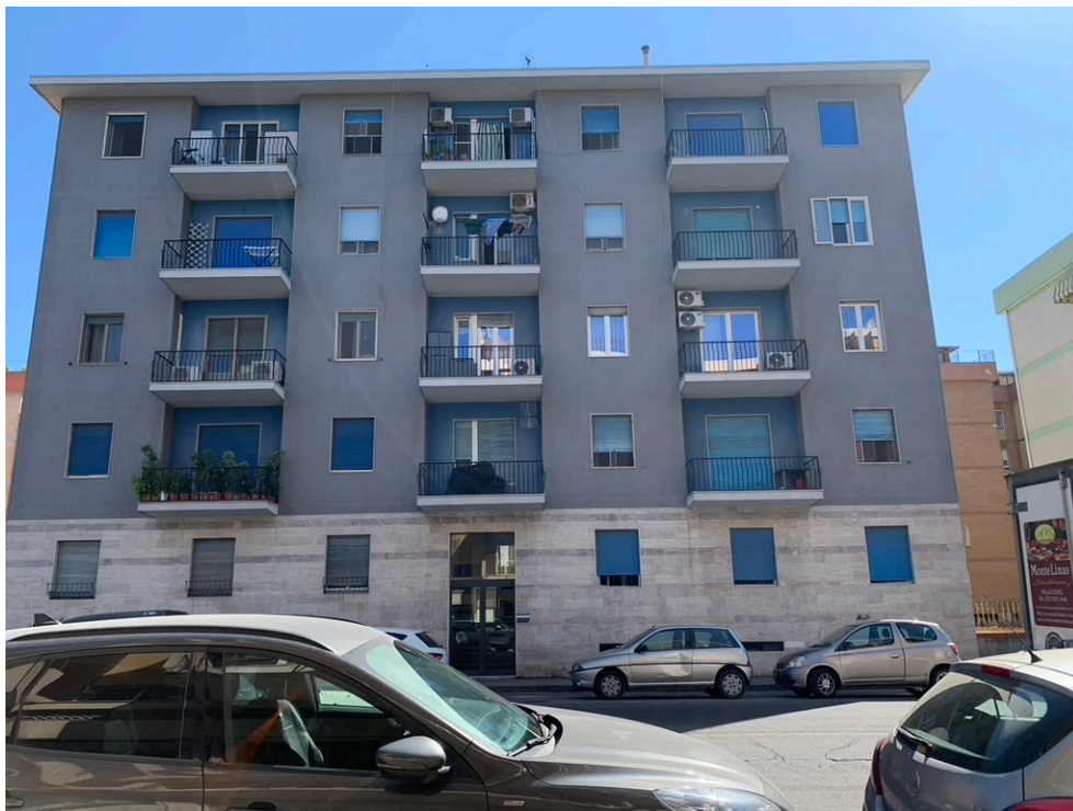
FOTO N. 19 VISTA ESTERNA - FABBRICATO CONDOMINIALE
