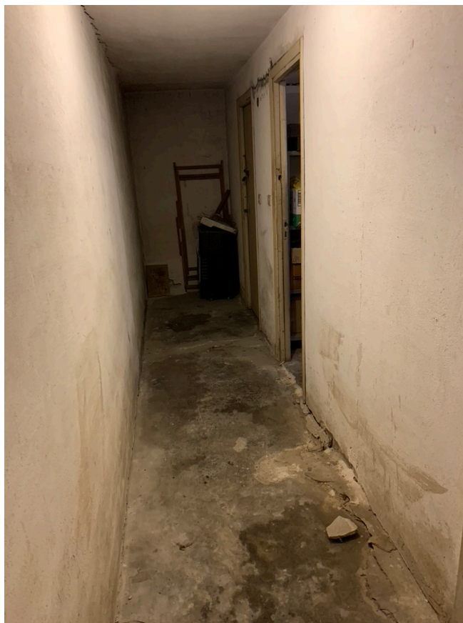
FOTO N. 18 VISTA INTERNA - CANTINA
