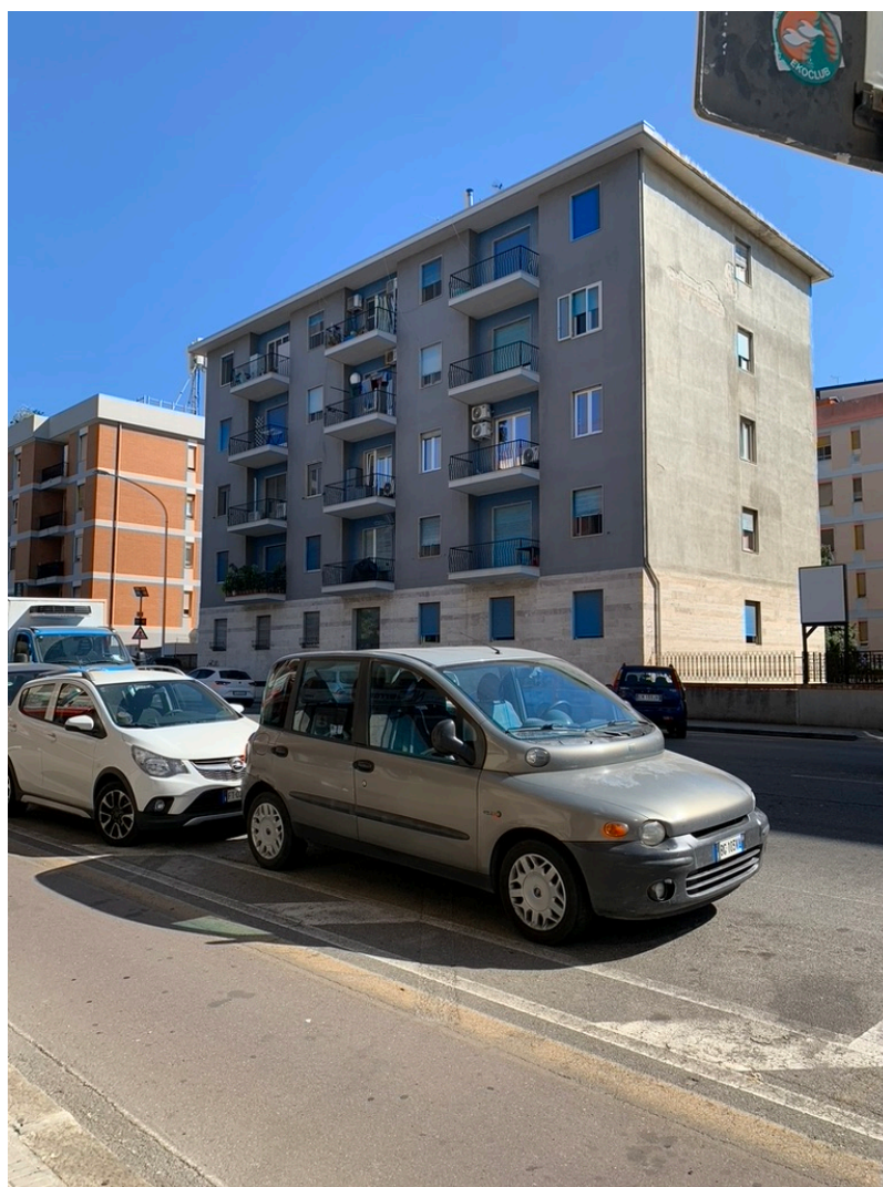
FOTO N. 20 VISTA ESTERNA - FABBRICATO CONDOMINIALE
