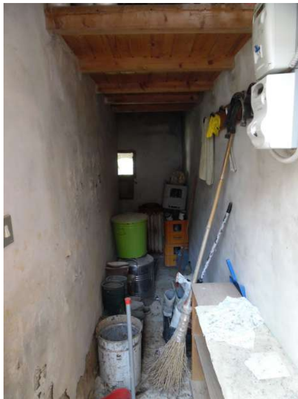
FOTO 26 – Vista vano sotto scala
